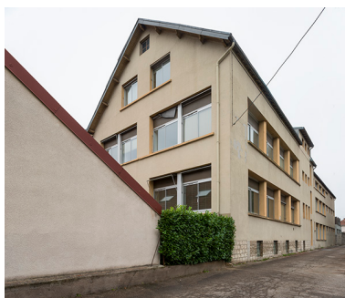
Atelier est vu de trois quarts. Phot. Jérôme Mongreville IVR43_20172501357NUC4A
