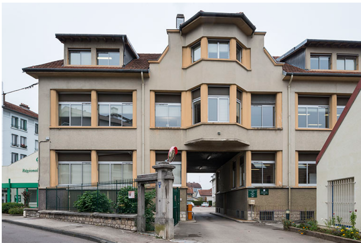
Bâtiment d'entrée. Façade antérieure.
