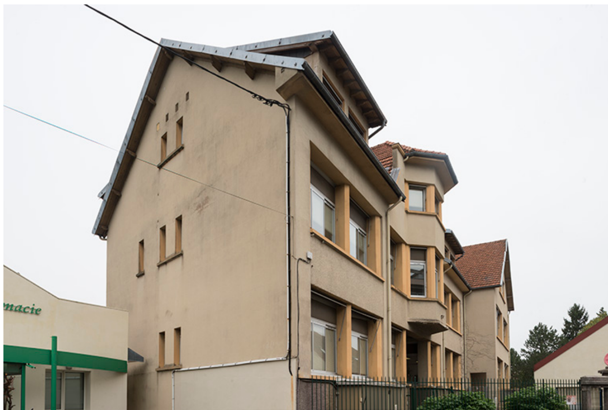
Bâtiment d'entrée vu de trois quarts.
