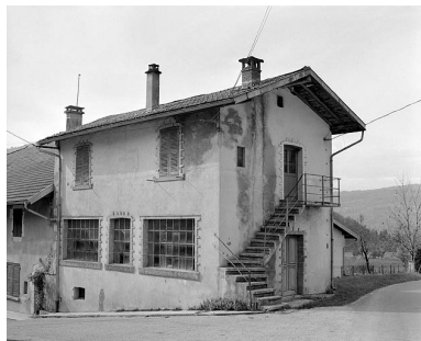
Façade longitudinale et pignon. Phot. Jérôme Mongreville IVR43_19943901252X
