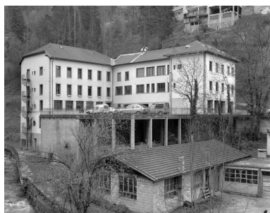
Ateliers de fabrication depuis l'ouest. Phot. Jérôme Mongreville IVR43_19923900350V
