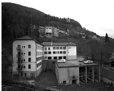
Ateliers de fabrication et séchoir à ébauchons. Phot. Jérôme Mongreville IVR43_19923900351V
