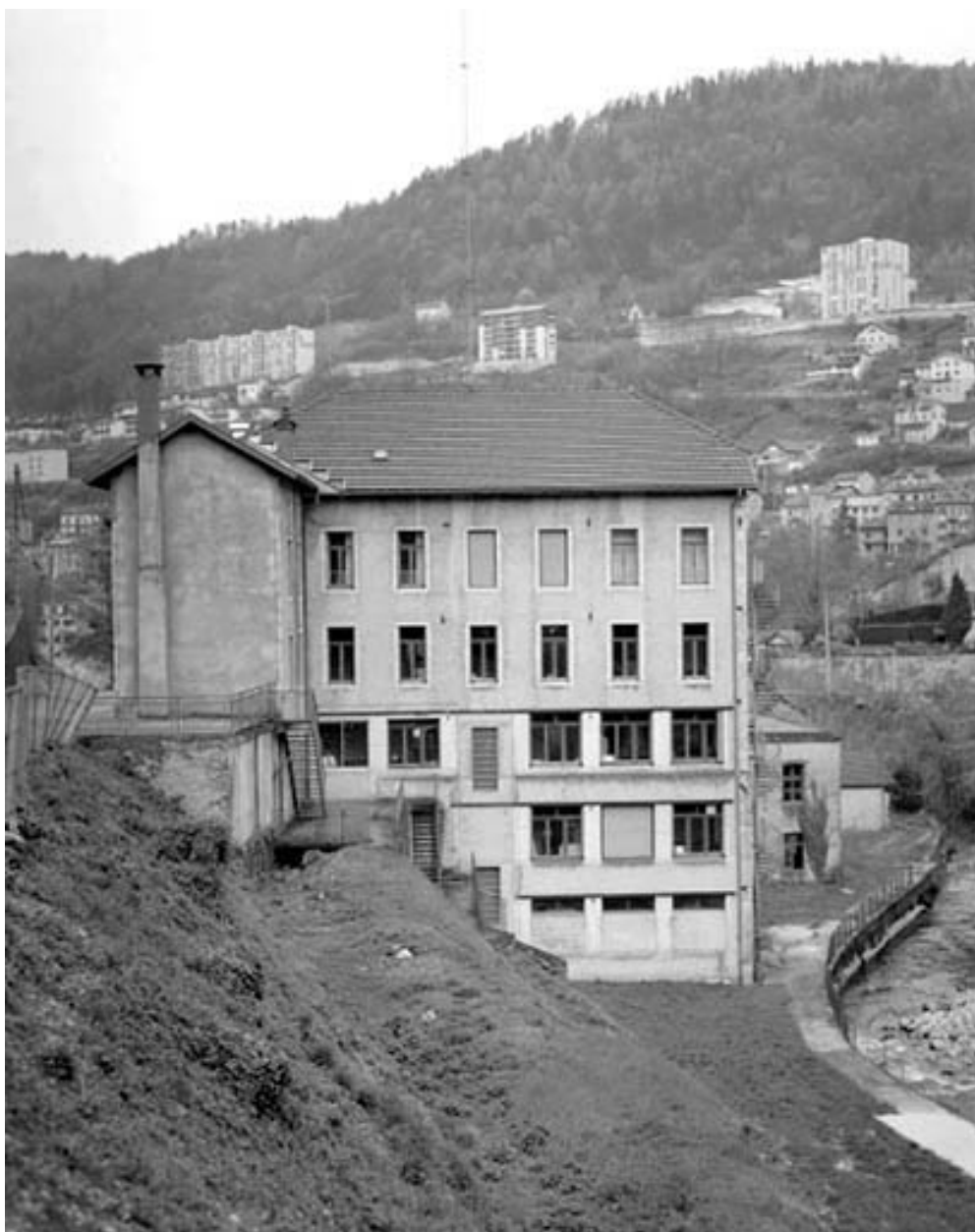
Ateliers de fabrication depuis l'est.
