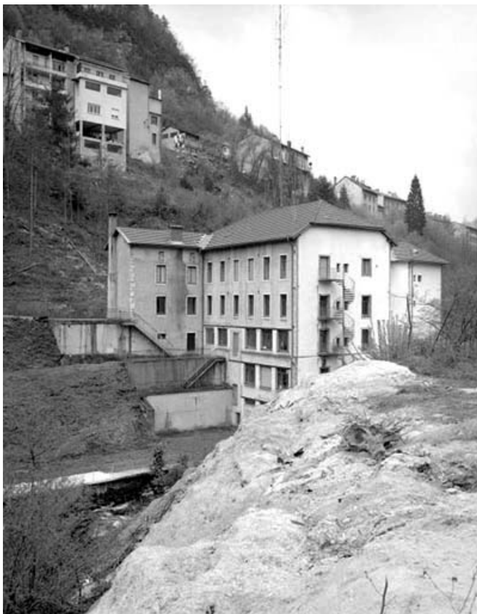
Ateliers de fabrication depuis le nord.
