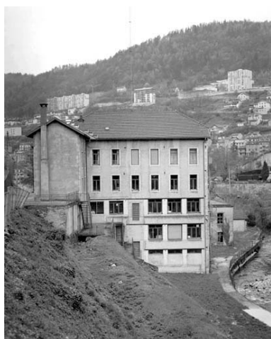
Ateliers de fabrication depuis l'est.
