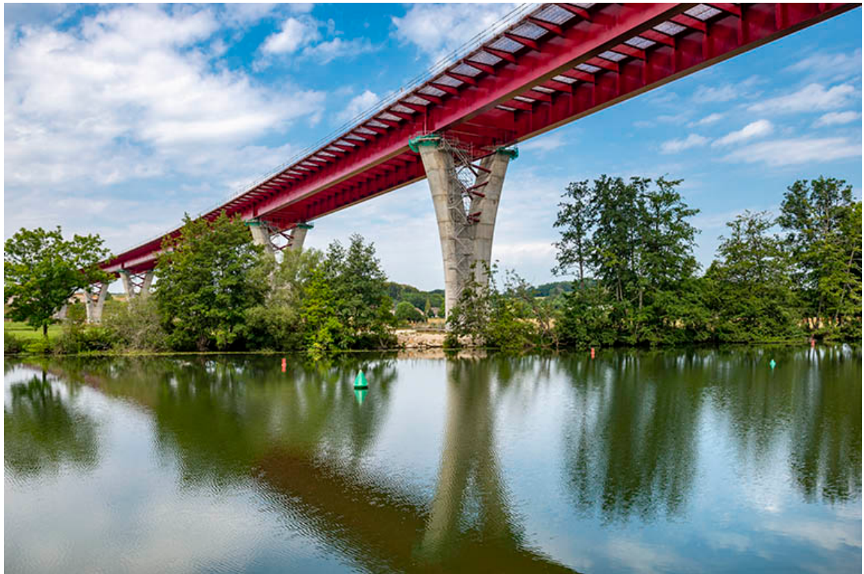
le viaduc en construction (déviation de Port-sur-Saône).
