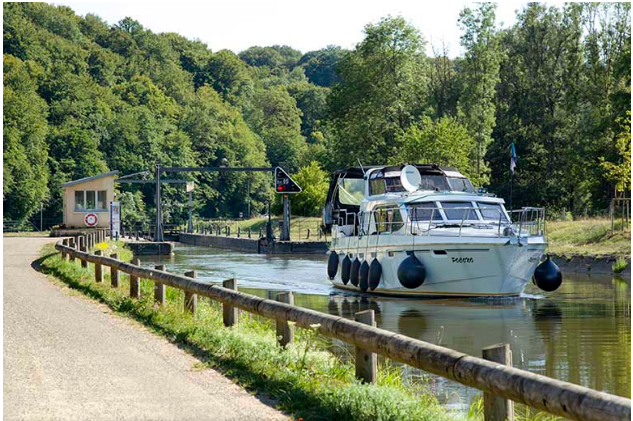
L'écluse de Port-sur-Saône.
