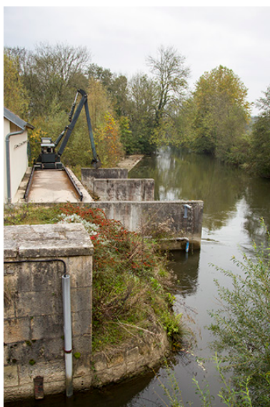
Appareil lié à l'entretien du canal. Phot. Sonia Dourlot IVR43_20157000194NUC2A
