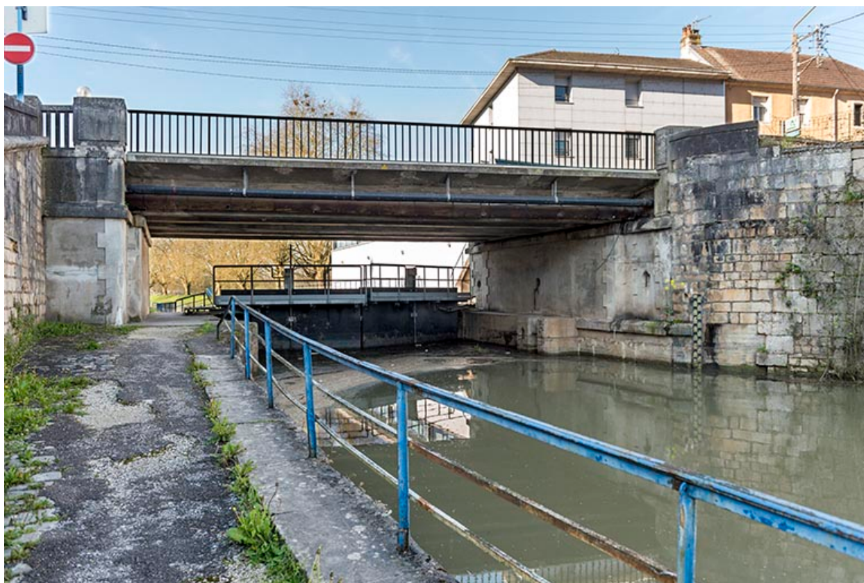
La porte de garde, vue depuis l'amont.
