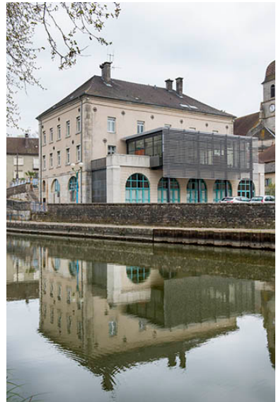
L'hôtel de ville de Port- sur-Saône et le canal. Phot. Jérôme Mongreville IVR43_20177000690NUC4A
