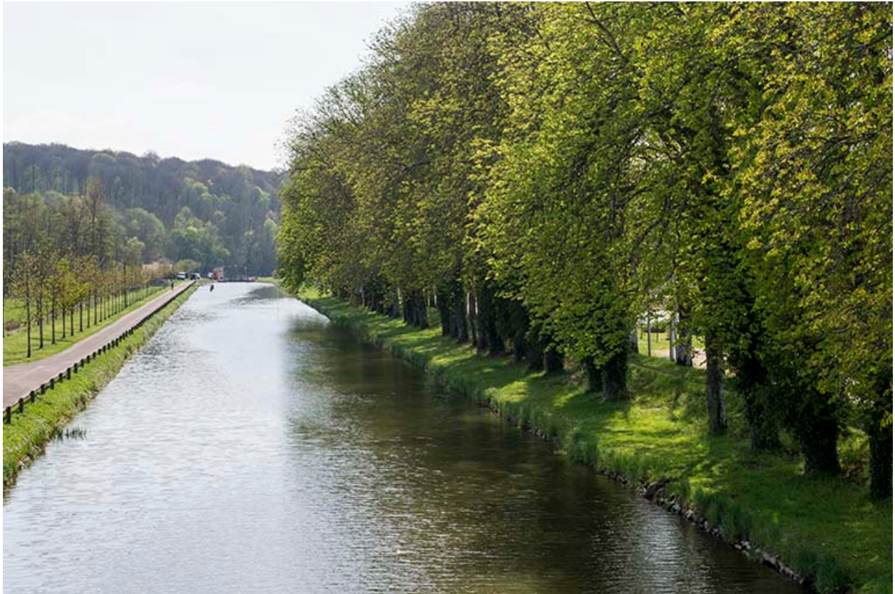
Vue générale du canal vers l'aval.
