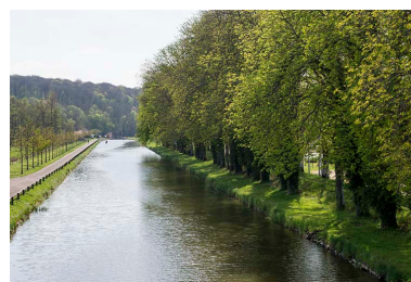
Vue générale du canal vers l'aval. Phot. Jérôme Mongreville IVR43_20177000663NUC4A
