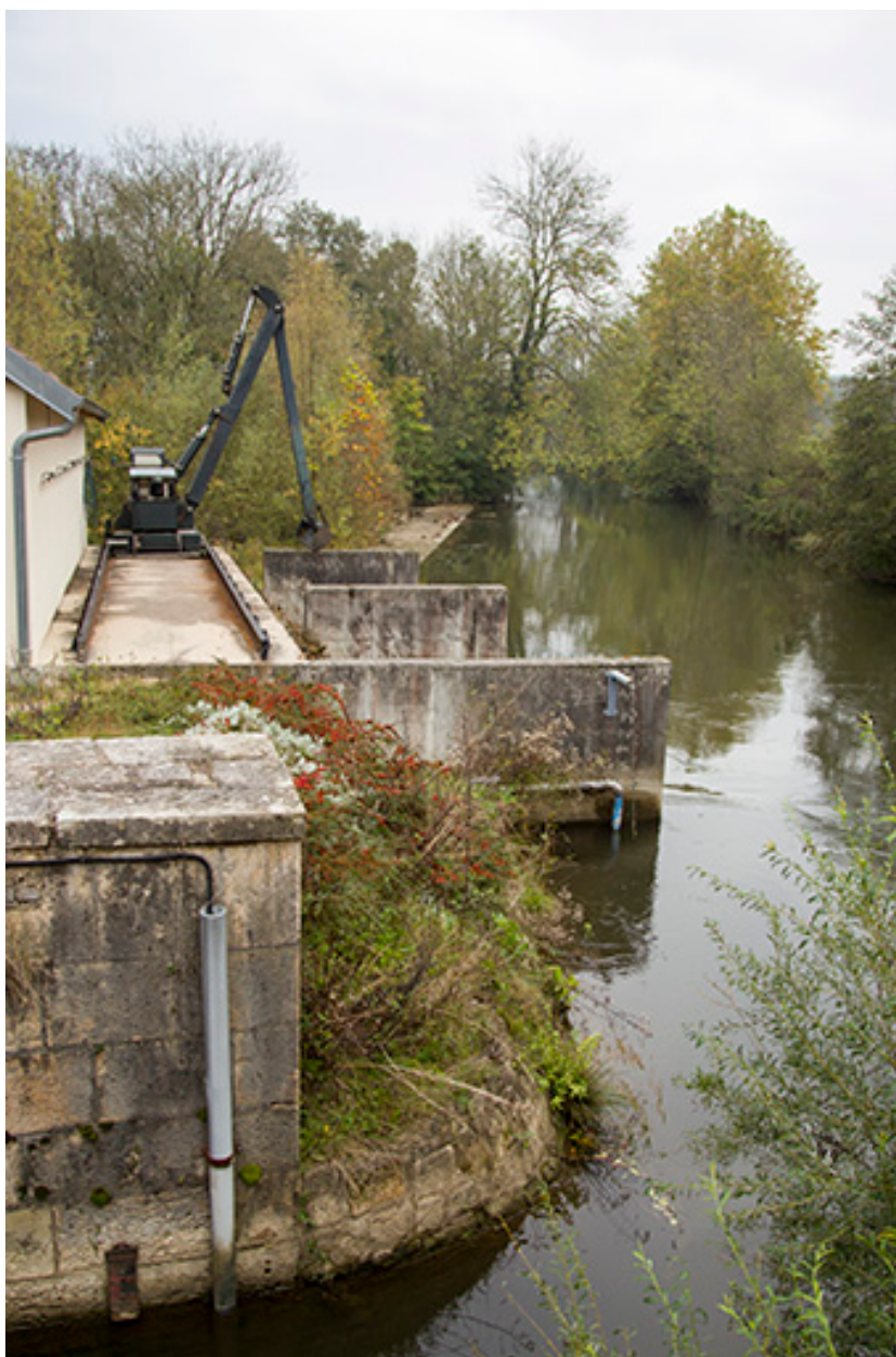
Appareil lié à l'entretien du canal.
