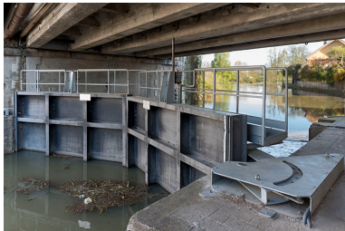
Détails des vantaux. Phot. Sonia Dourlot IVR43_20167000320NUC4A
