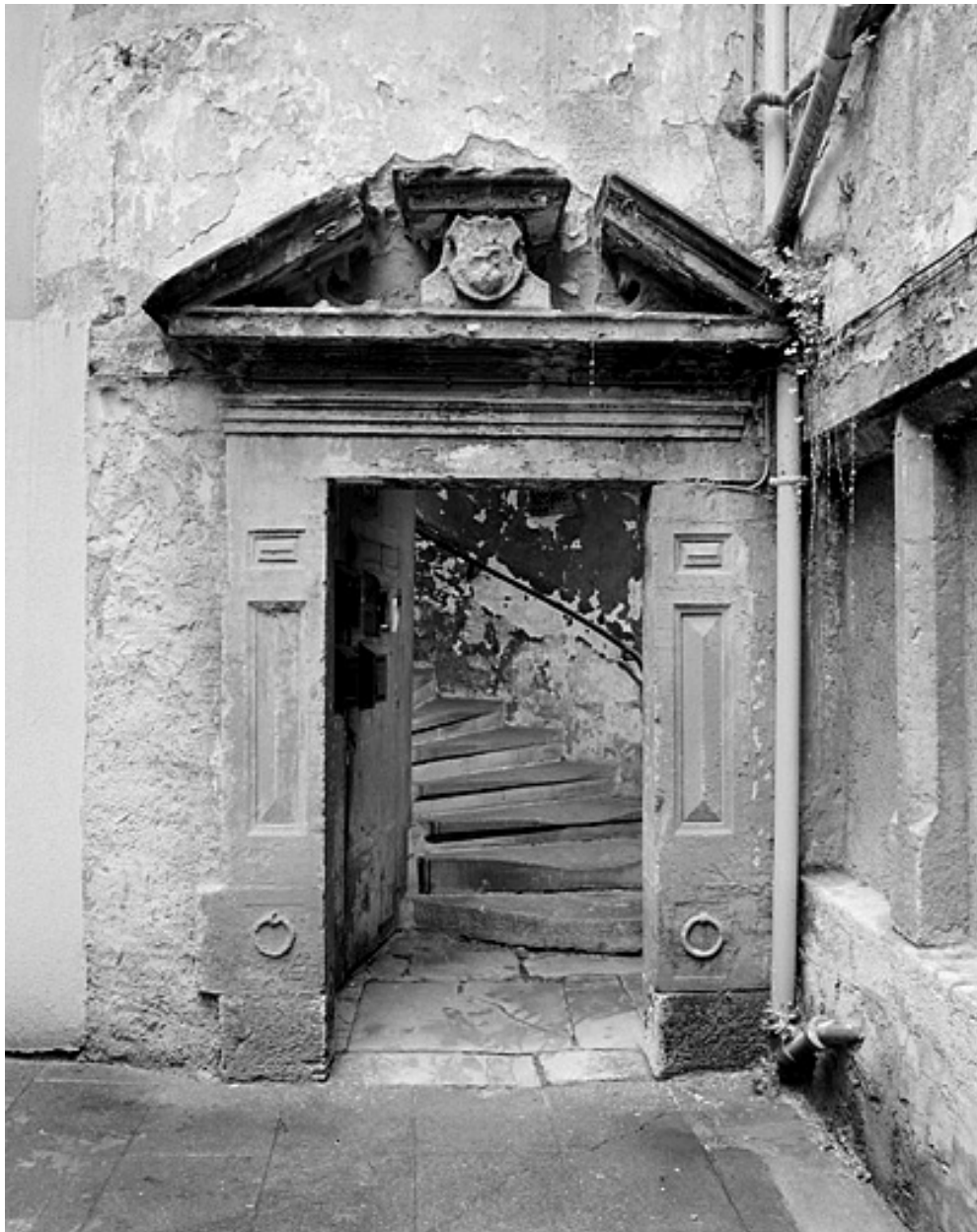
Porte de la tour d'escalier.
