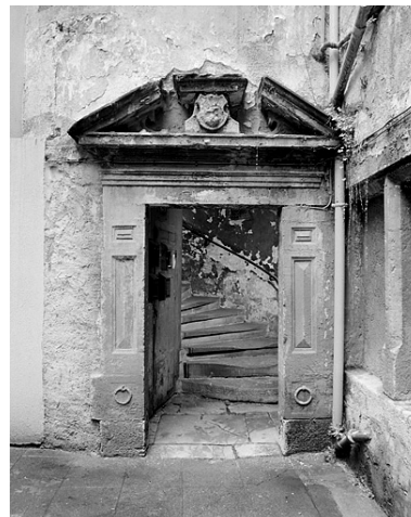
Porte de la tour d'escalier.
