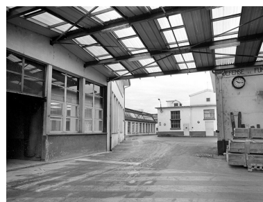
Ateliers de fabrication depuis l'est. Phot. Yves Sancey IVR43_20019000457X
