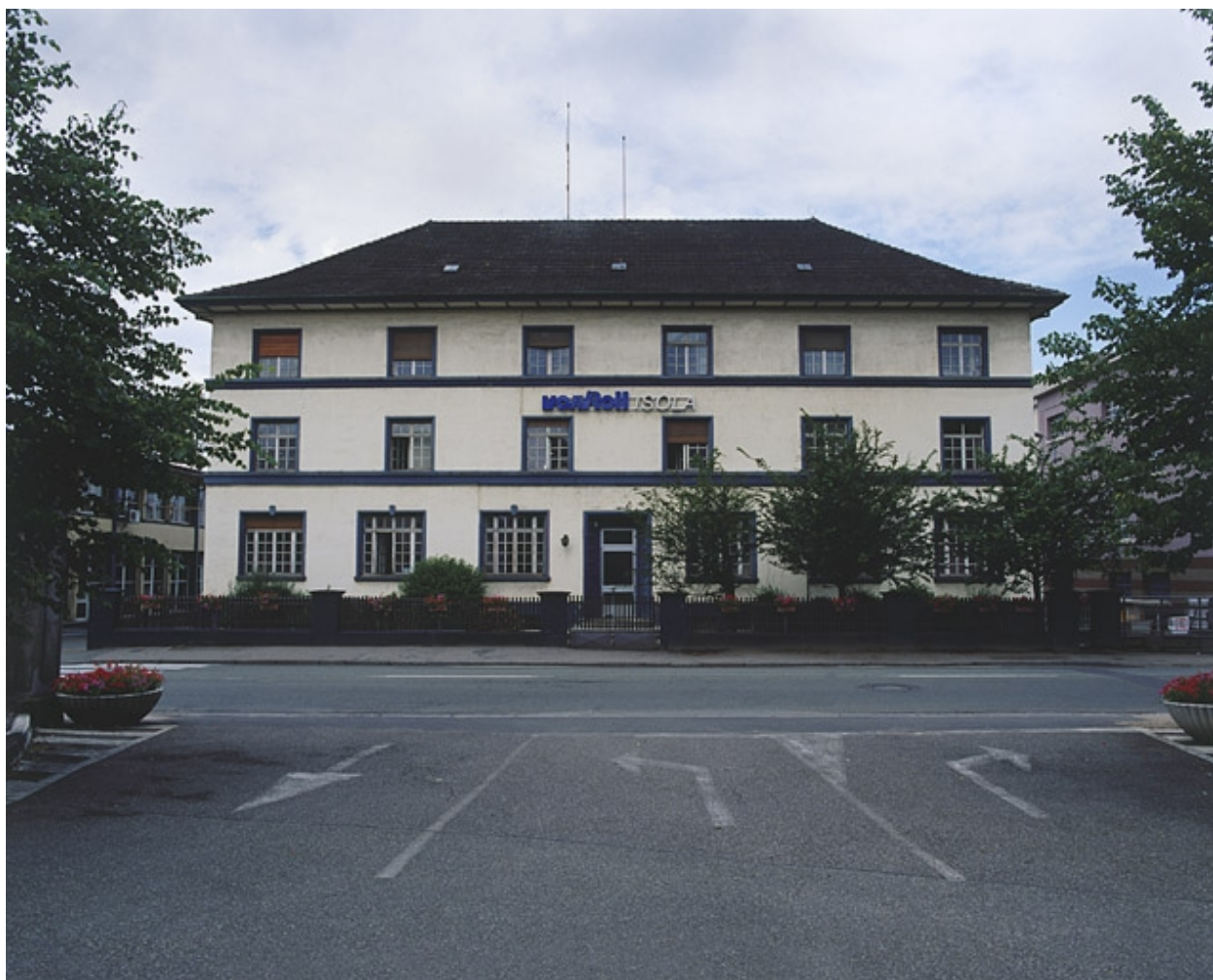
Bureaux (anciens logements).
