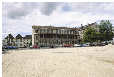
Vue rapprochée depuis l'est. Phot. Yves Sancey IVR43_20019000472ZA
