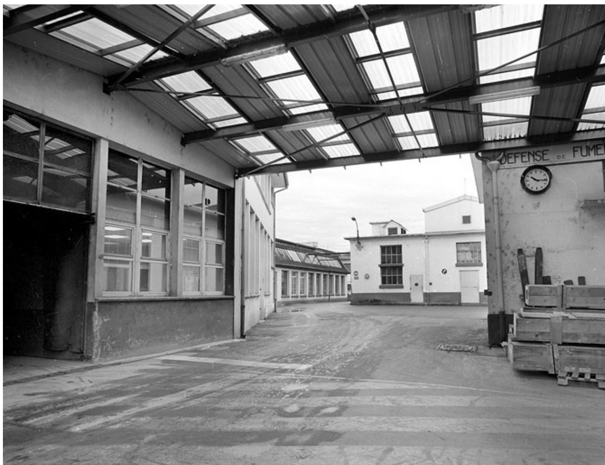
Ateliers de fabrication depuis l'est.
