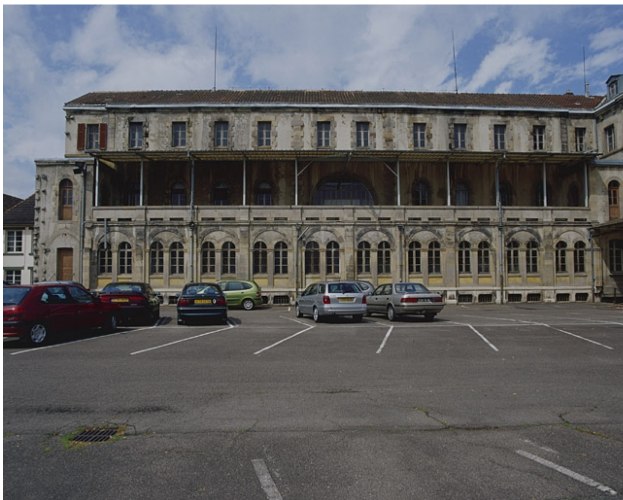
Façade postérieure de l'ancien couvent (actuellement bureaux).
