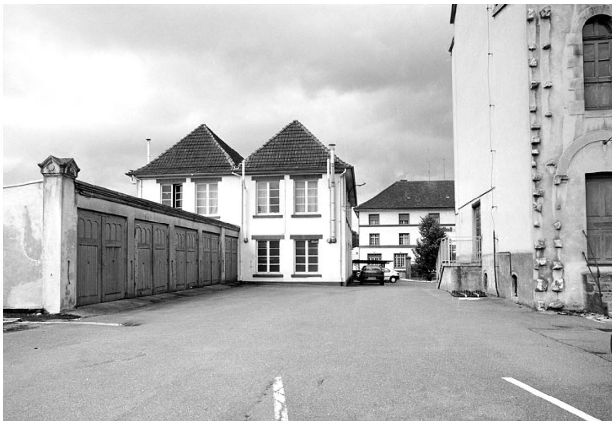
Remises et laboratoire depuis l'est.
