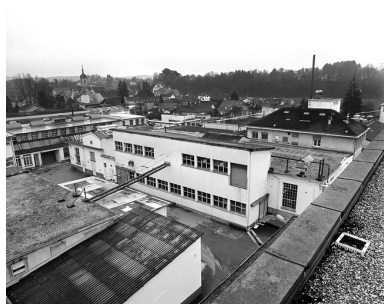
Vue plongeante vers le sud-ouest. Phot. Yves Sancey IVR43_20019000458X
