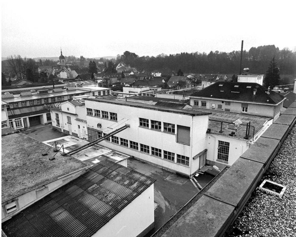
Vue plongeante vers le sud-ouest.
