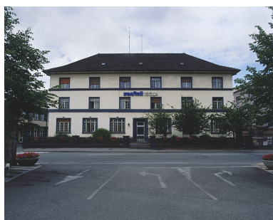
Bureaux (anciens logements). Phot. Yves Sancey IVR43_20029000429XA
