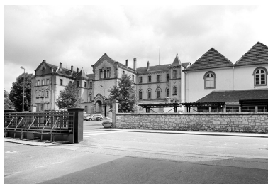
Bâtiment administratif (ancien couvent) et laboratoire. Phot. Yves Sancey IVR43_20029000434X
