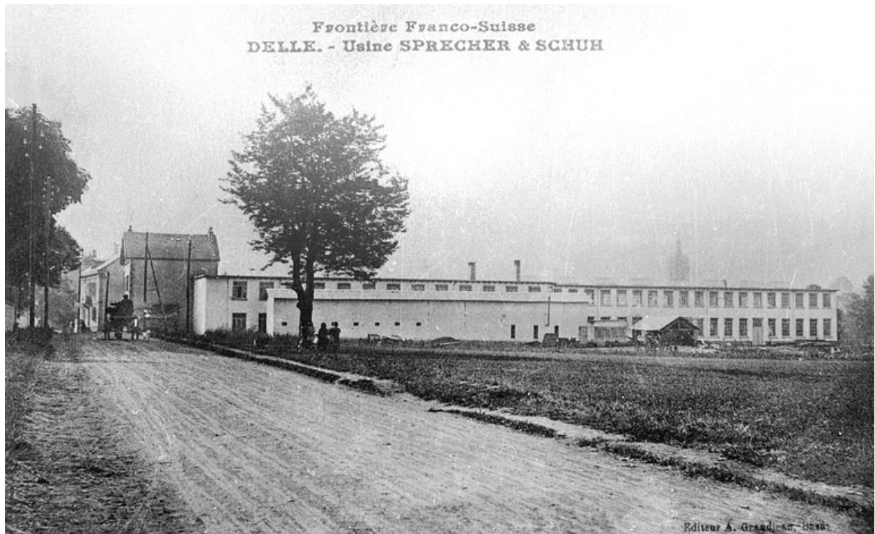
Delle. - Usine Sprecher & Schuh.
