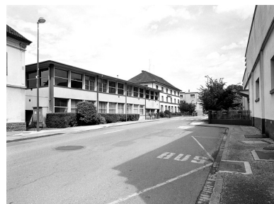
Façades sur rue de bâtiments administratifs. Phot. Yves Sancey IVR43_20029000430X
