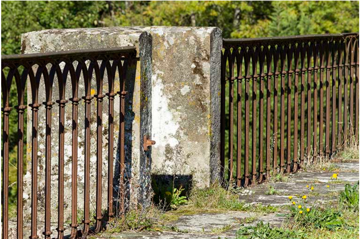
Le garde-corps maçonné d'une culée.
