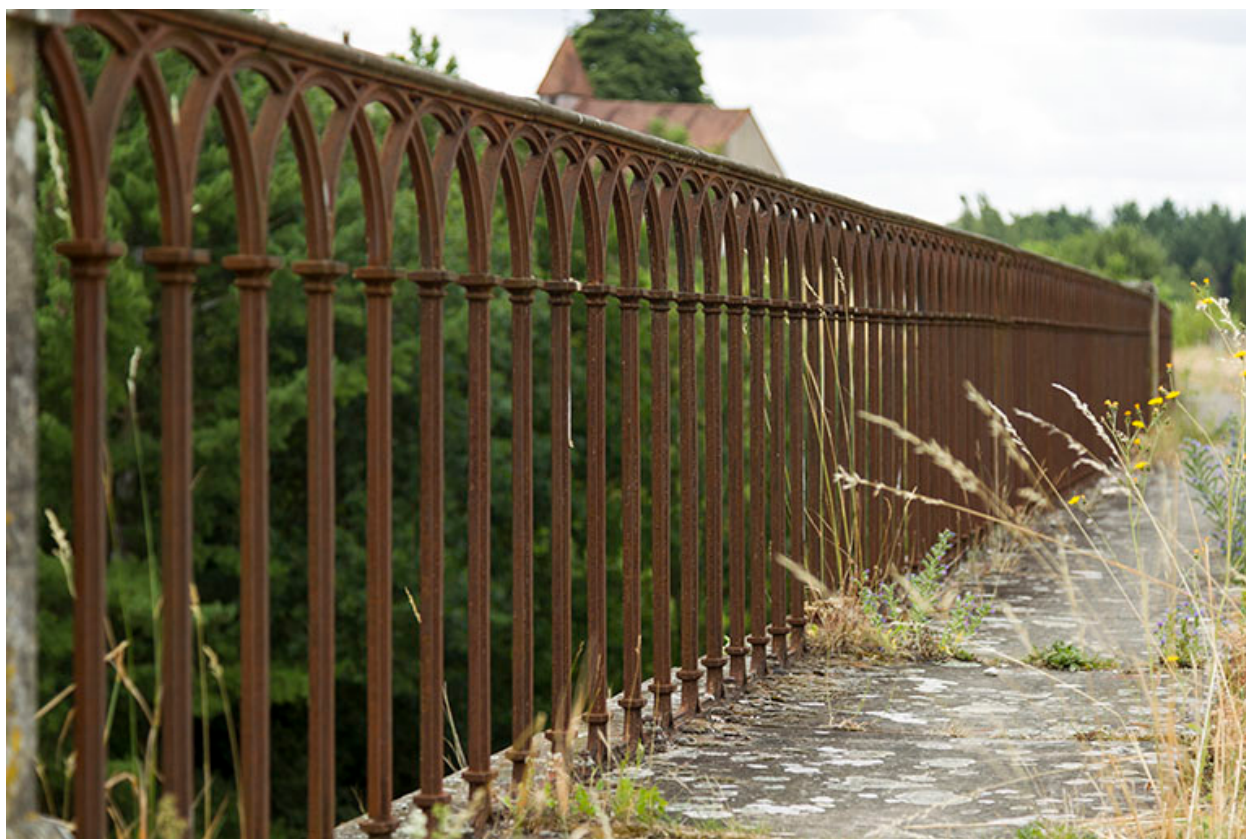
Détail du garde-corps.
