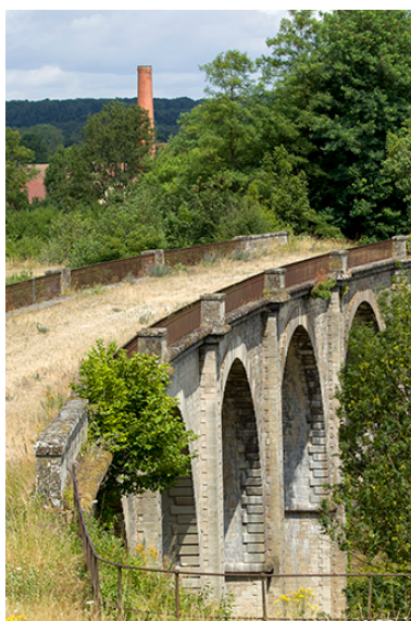
Le tablier du viaduc. Phot. Sonia Dourlot IVR43_20157000582NUC2A
