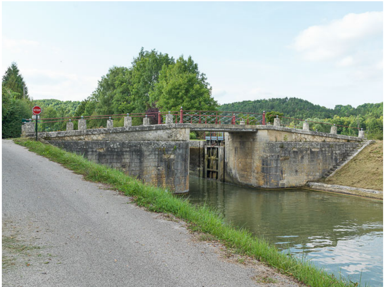
Vue d'ensemble du pont.
