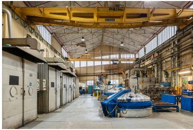
Atelier d'imprégnation. Vue d'ensemble. Phot. Jérôme Mongreville IVR43_20162500154NUC4A
