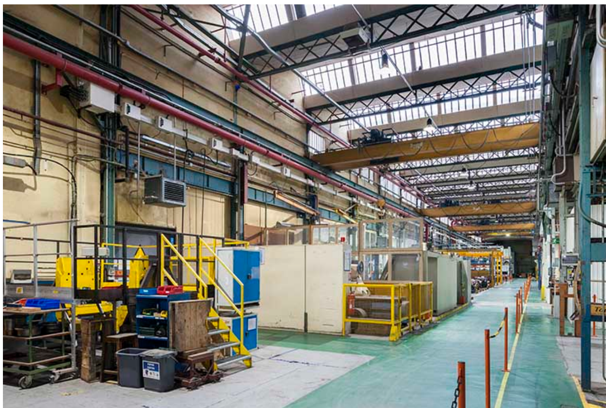
Hall central. Vue de côté.
