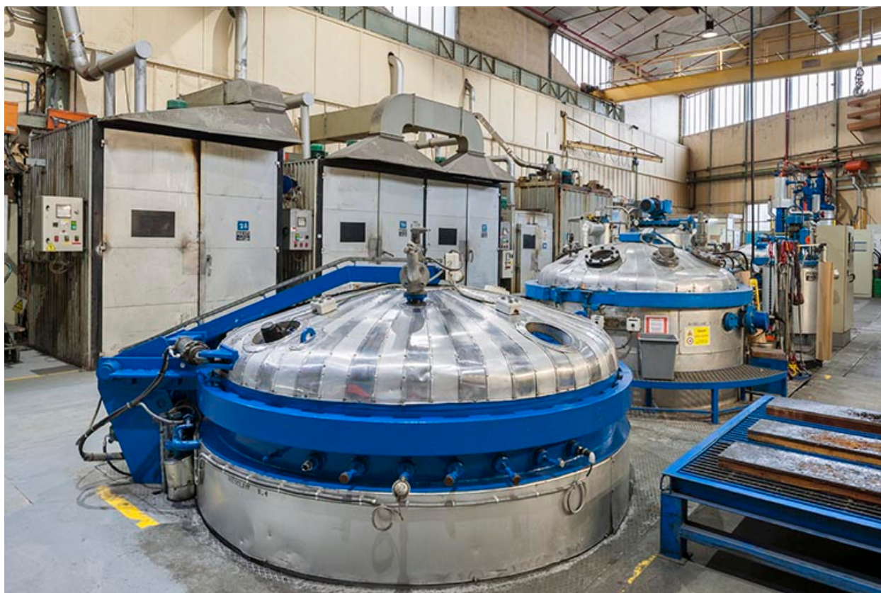
Autoclaves (imprégnation de vernis des stators).
