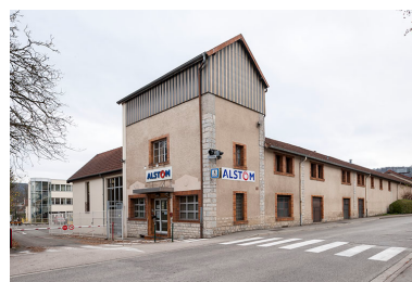
Entrée de l'usine. Phot. Jérôme Mongreville IVR43_20162500193NUC4A
