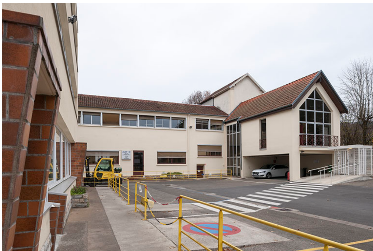
Bâtiments d'entrée (conciergerie et bureaux).
