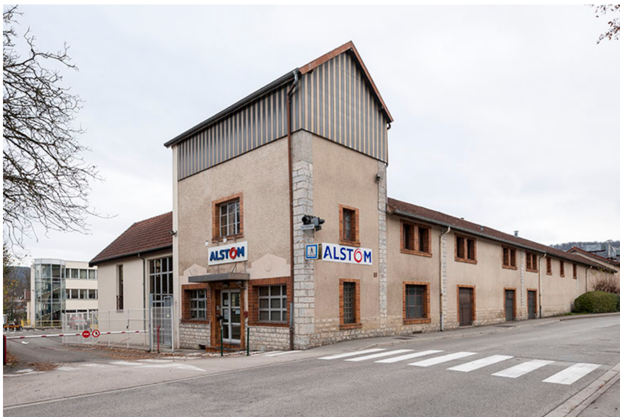
Entrée de l'usine.
