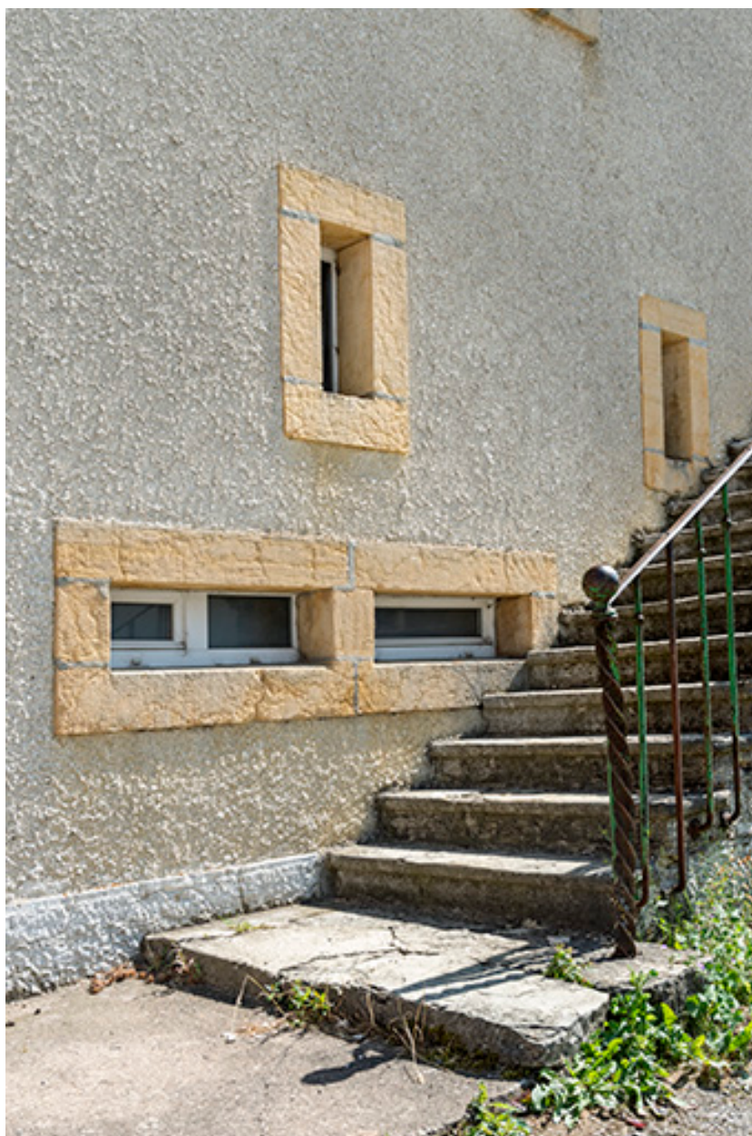
Baies fromagères horizontales sur la façade nord.
