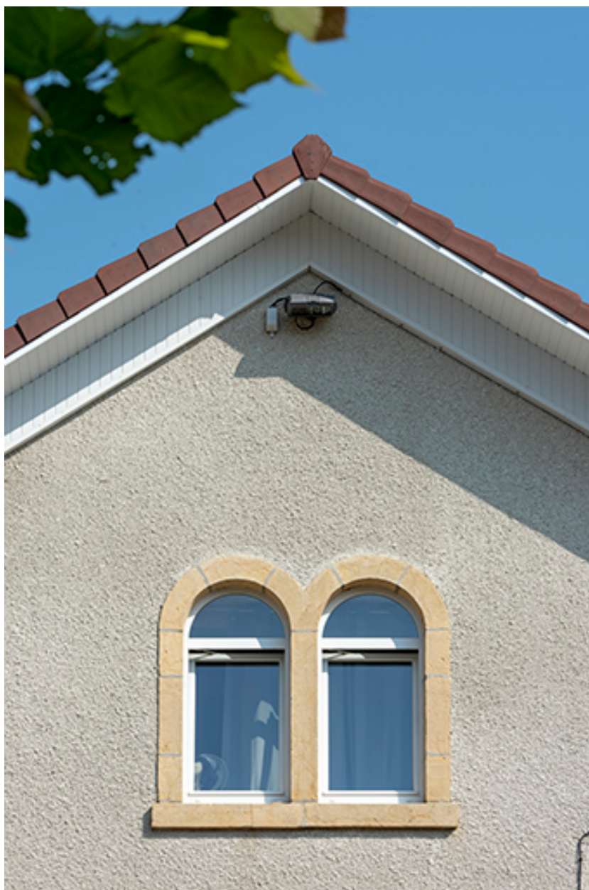
Façade sud : baie géminée dans le pignon.
