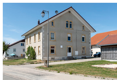
Façades sud et ouest. Phot. Sonia Dourlot IVR43_20192500643NUC4A
