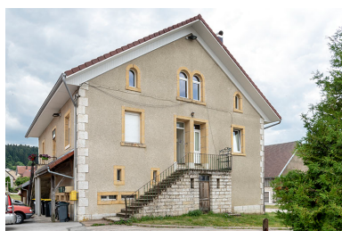
Façade nord, de trois quarts gauche. Phot. Sonia Dourlot IVR43_20192500642NUC4A
