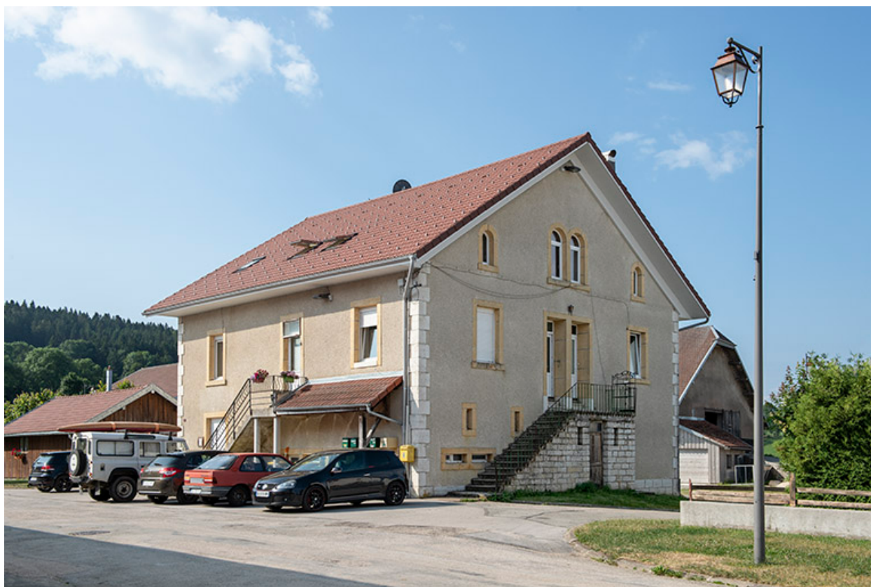
Façades nord et est.
