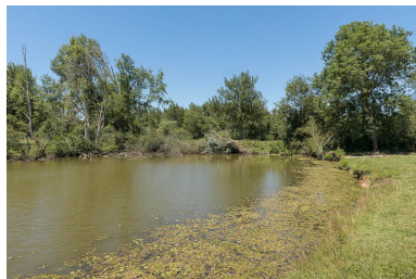
Vue de la digue.
