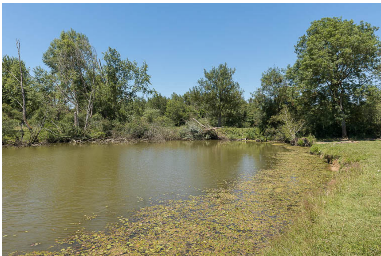
Vue de la digue.
