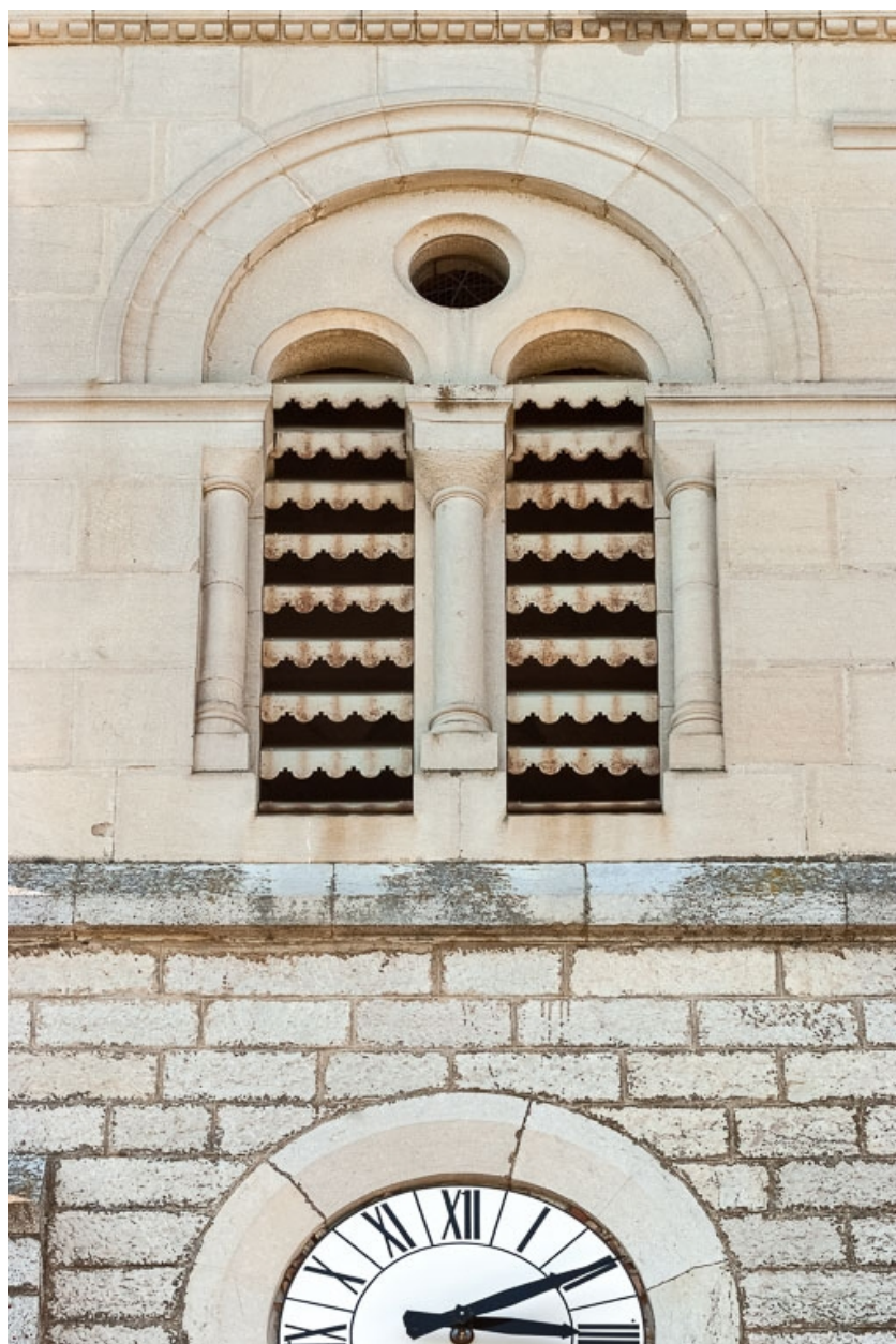
Clocher, détail des baies de l'élévation est.
