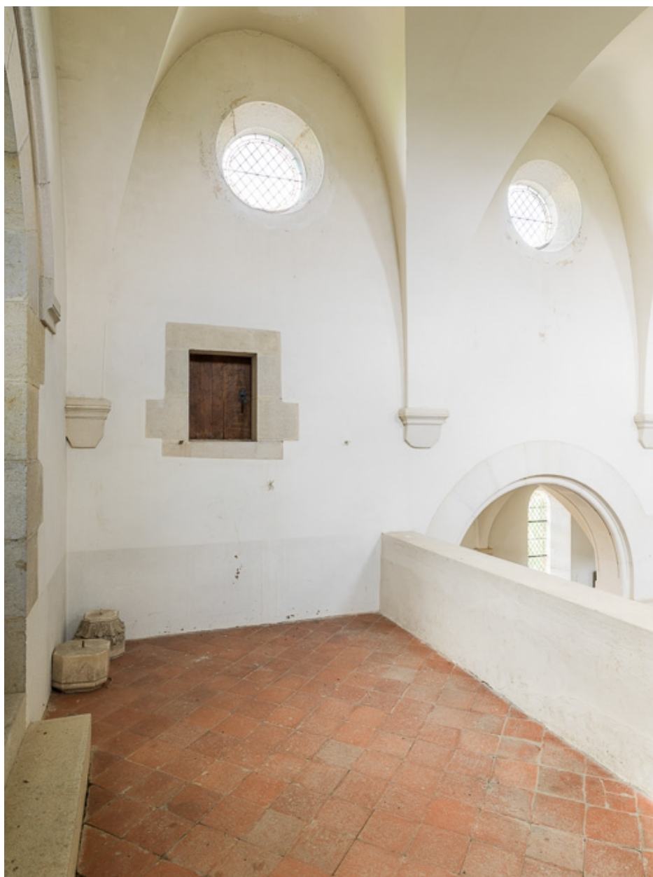
Tribune, oculus et accès aux combles.
