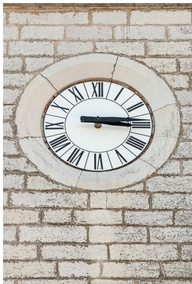
Clocher, détail du cadran de l'horloge. Phot. Pierre-Marie Barbe-Richaud IVR26_20162100271NUC2A
