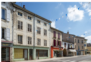
La rue Gambetta : n° ° 66 et précédents. Phot. Jérôme Mongreville IVR43_20217000634NUC4A
