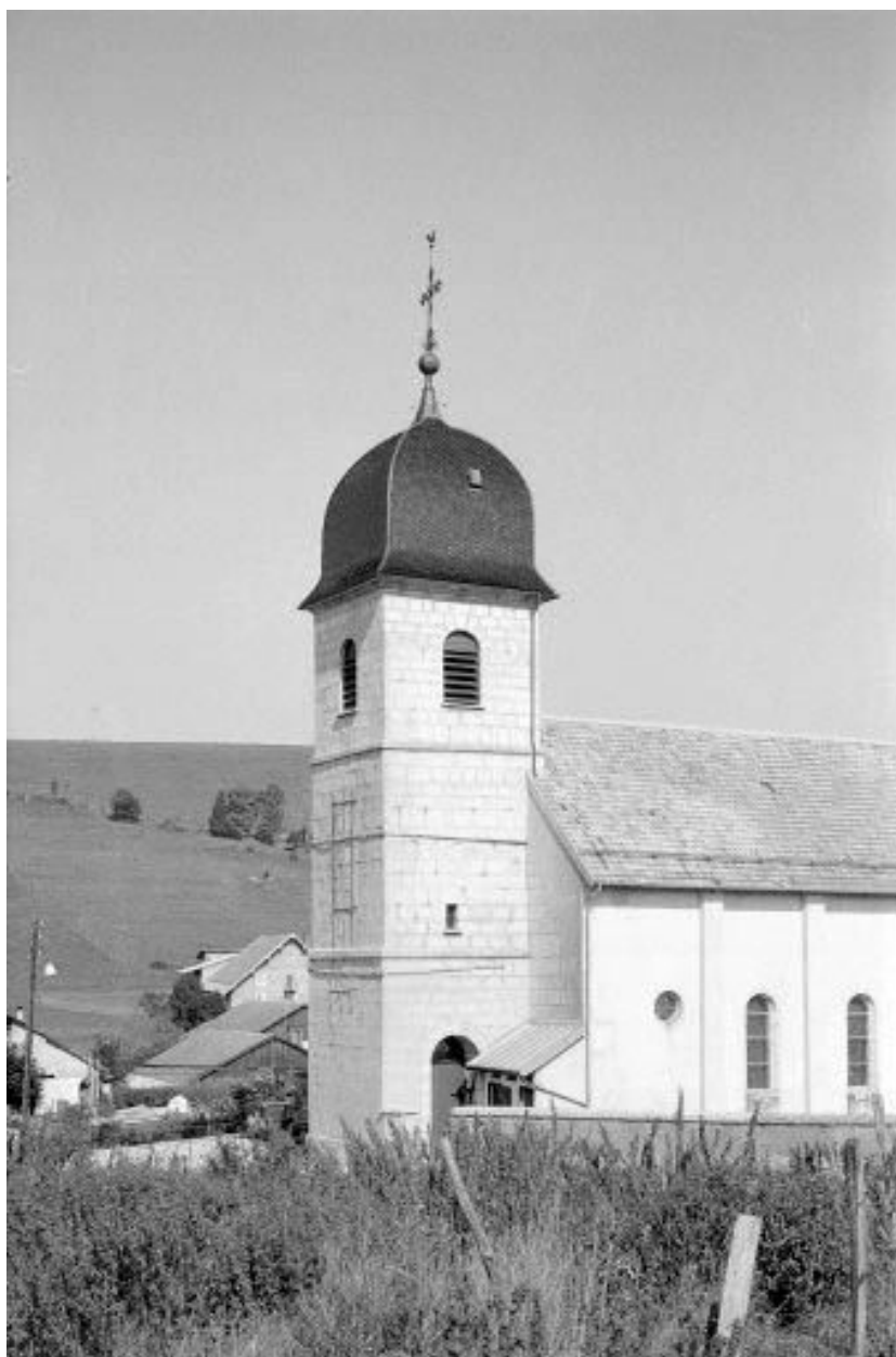
Le clocher et la façade latérale droite.
