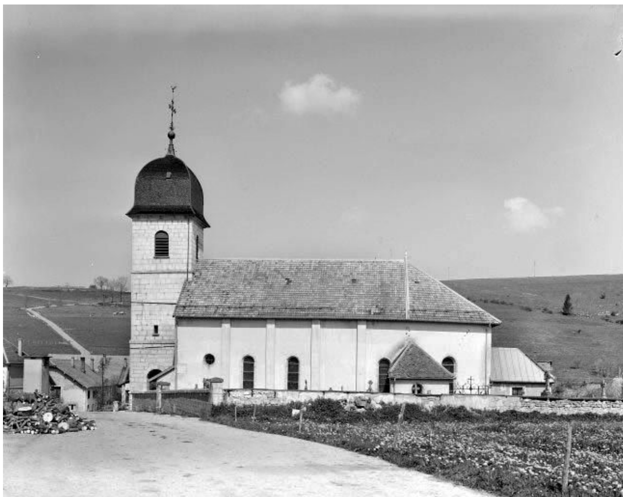
Extérieur : façade latérale droite.
