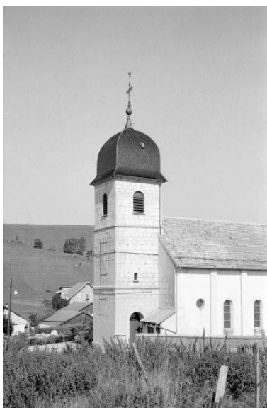
Le clocher et la façade latérale droite. Phot. Yves Sancey IVR43_19742500118Z
