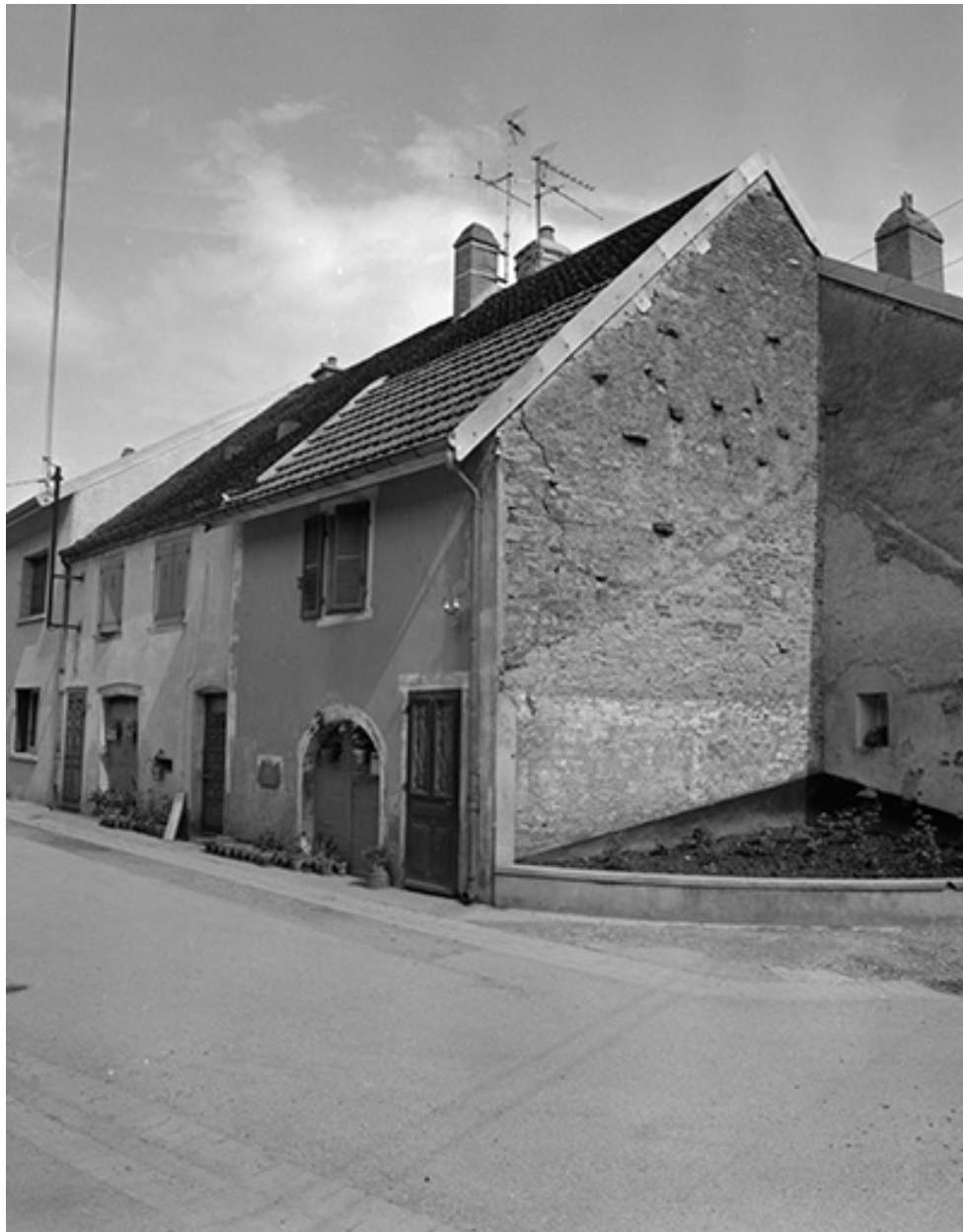
Façades antérieure et latérale droite.
