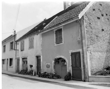
Façade antérieure vue de trois-quarts droit. Phot. Yves Sancey IVR43_19793900239X
