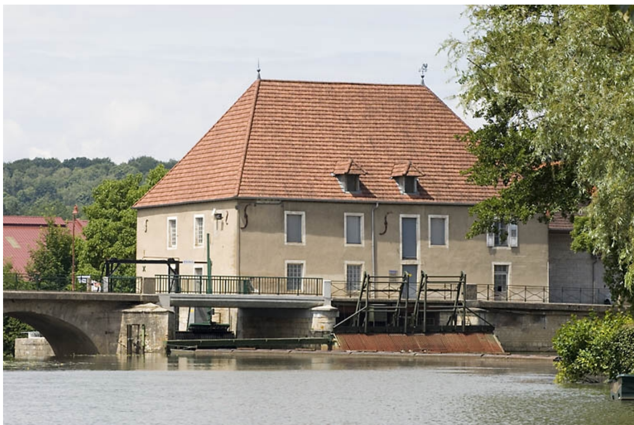
Vue d'ensemble en amont de la Saône.
