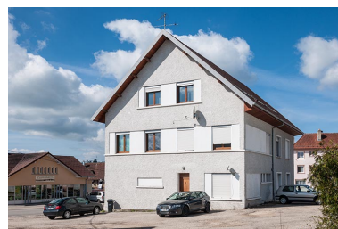
Façades latérale droite et postérieure (montrant les fenêtres d'atelier). Phot. Jérôme Mongreville IVR43_20142500207NUC4A
