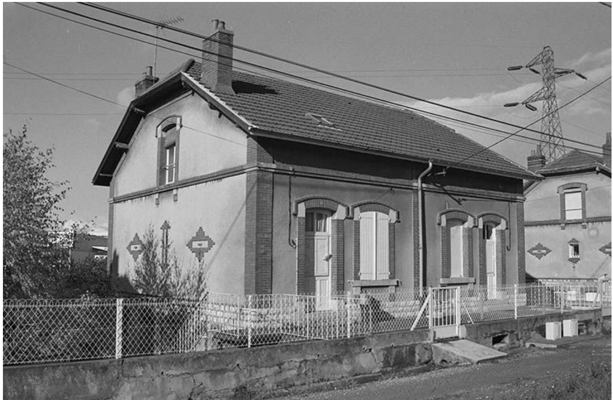
Bâtiment à deux logements ouvriers de " type 4 ".
