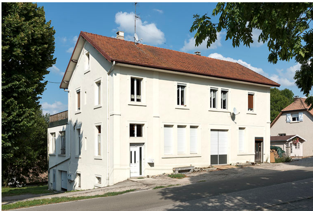
Façades antérieure et latérale gauche.
