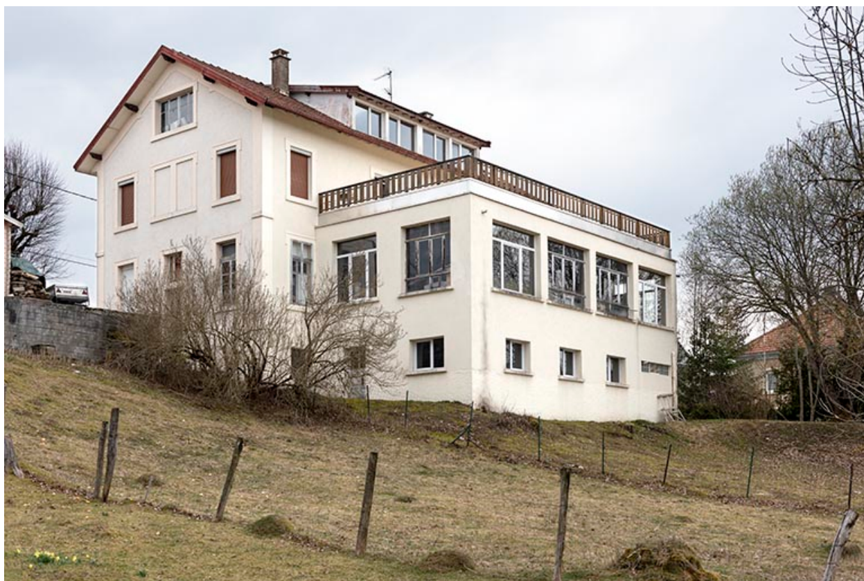
Façades postérieure et latérale droite.
