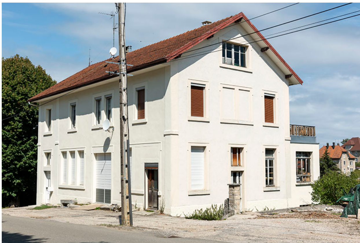
Façades antérieure et latérale droite.
