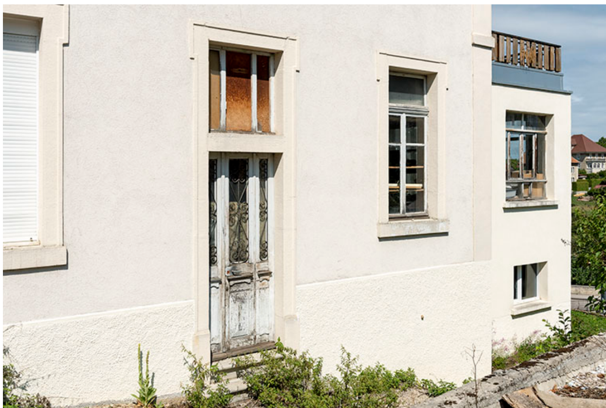
Façade latérale droite : baies du rez-de-chaussée.
