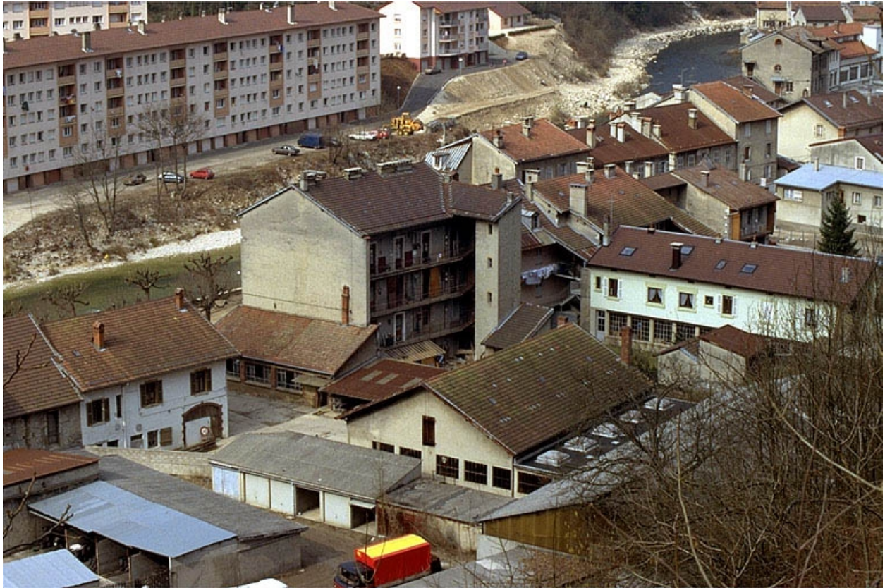
Vue d'ensemble plongeante depuis le sud-est.
