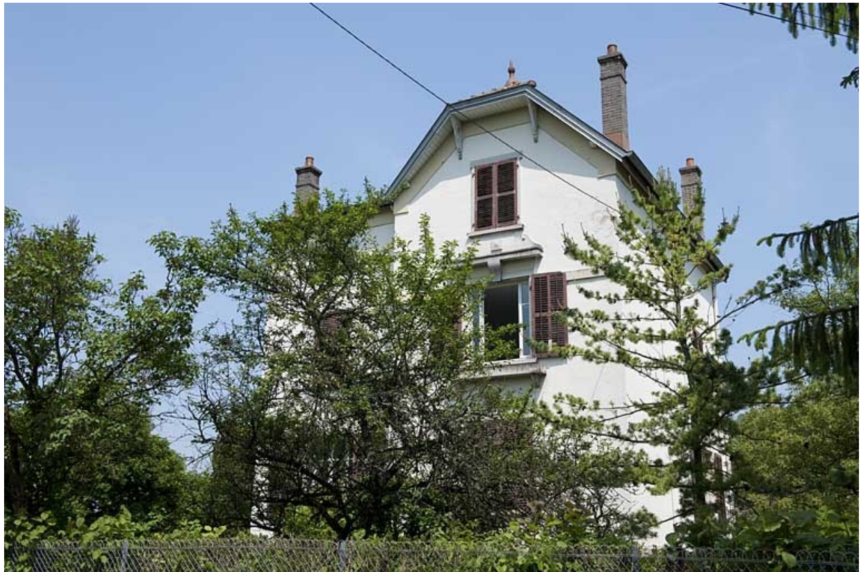
Etage supérieure d'une maison.
