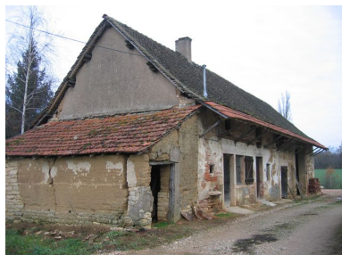
Vue d'ensemble de la façade.
