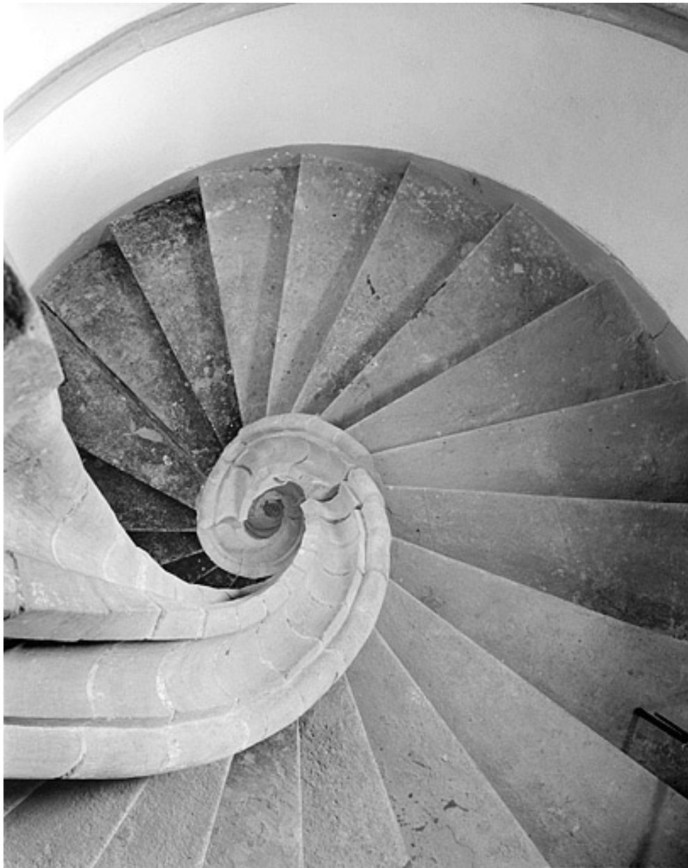
Escalier vu du niveau des combles.
