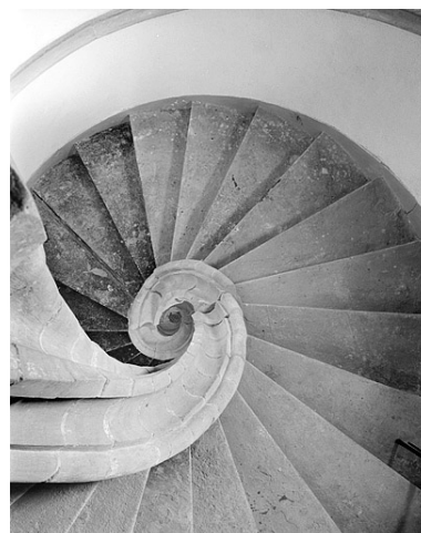
Escalier vu du niveau des combles. Phot. Jérôme Mongreville IVR43_19872500465X
