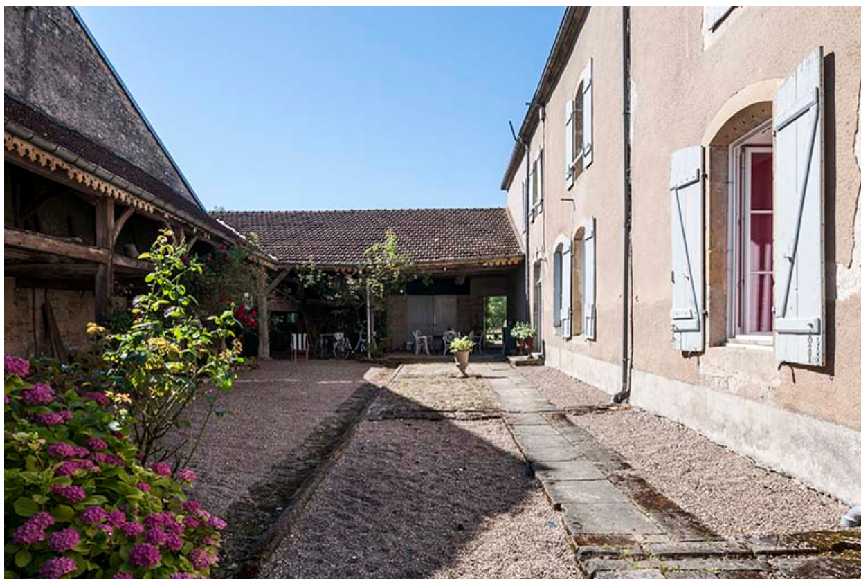
La cour, façade est.
