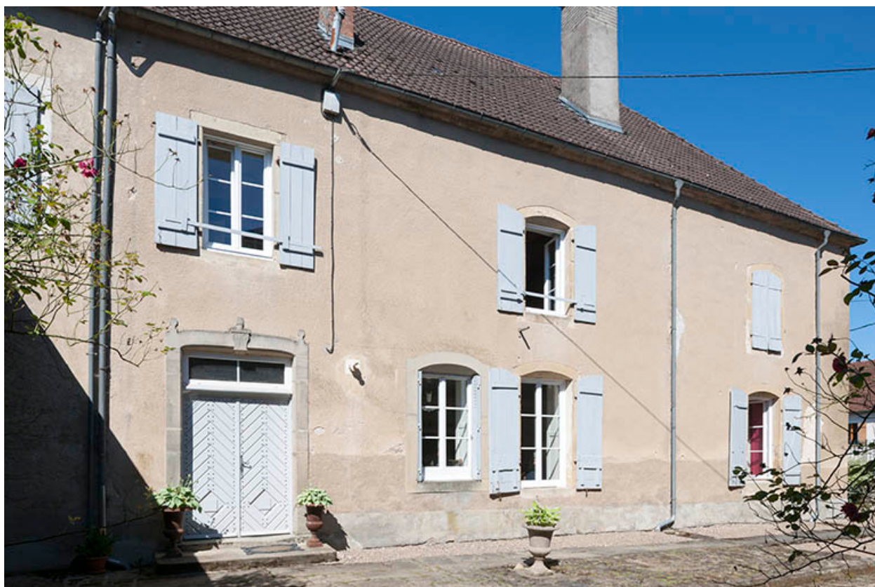
Vue générale, façade est.
