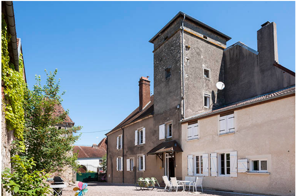
Vue générale, façade ouest.
