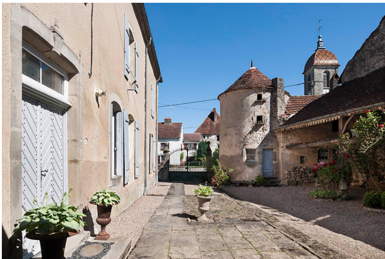
La cour, façade est.
