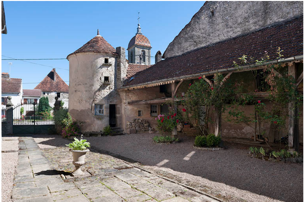
La cour, façade est.
