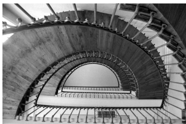
L'escalier tournant. Phot. Laurent Poupard IVR43_19883900292Z
