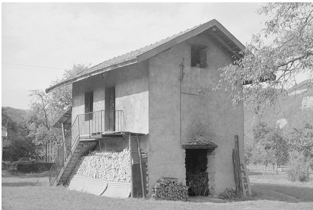
Bâtiment du four et du logement d'ouvriers.
