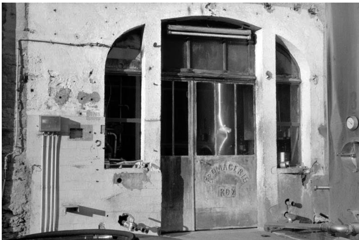
Porte d'entrée de l'atelier de fabrication.
