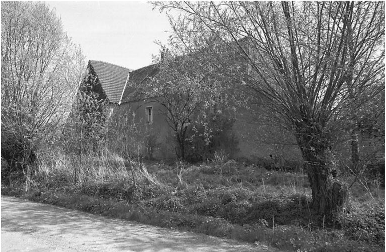
Façade latérale droite.
