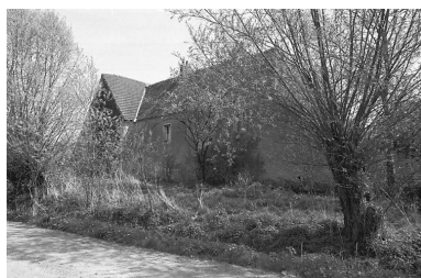
Façade latérale droite.
