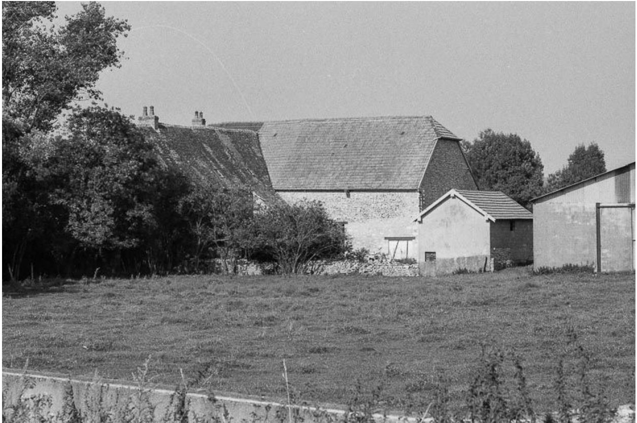
Façade sur cour.
