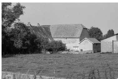
Façade sur cour.
