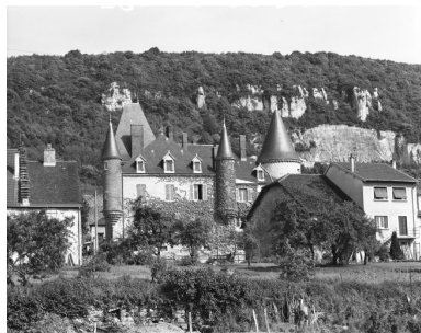
Vue de situation en 1981. Phot. Yves Sancey IVR43_19813900132X
