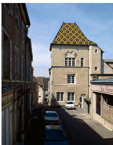
Maison située 12 rue des Terreaux. Phot. Yves Sancey IVR43_19987000051XA
