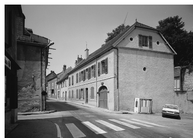
Maisons situées 2 rue Rossen. Phot. Yves Sancey IVR43_19897000468V
