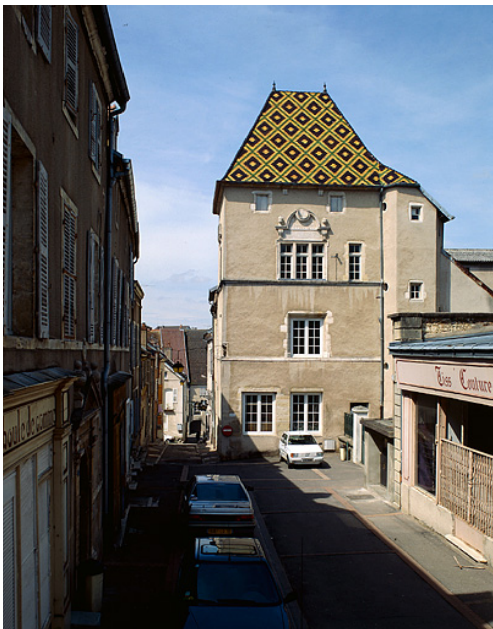
Maison située 12 rue des Terreaux.
