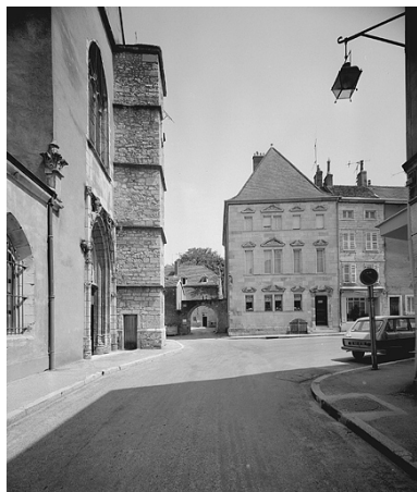
maison Paguelle de Larret située 12 rue de l'Eglise. Phot. Yves Sancey IVR43_19897000393V
