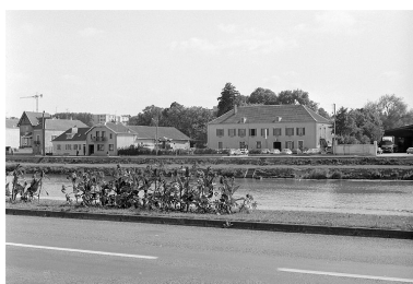
Maisons situées quai Mavia. Phot. Yves Sancey IVR43_19887000174X
