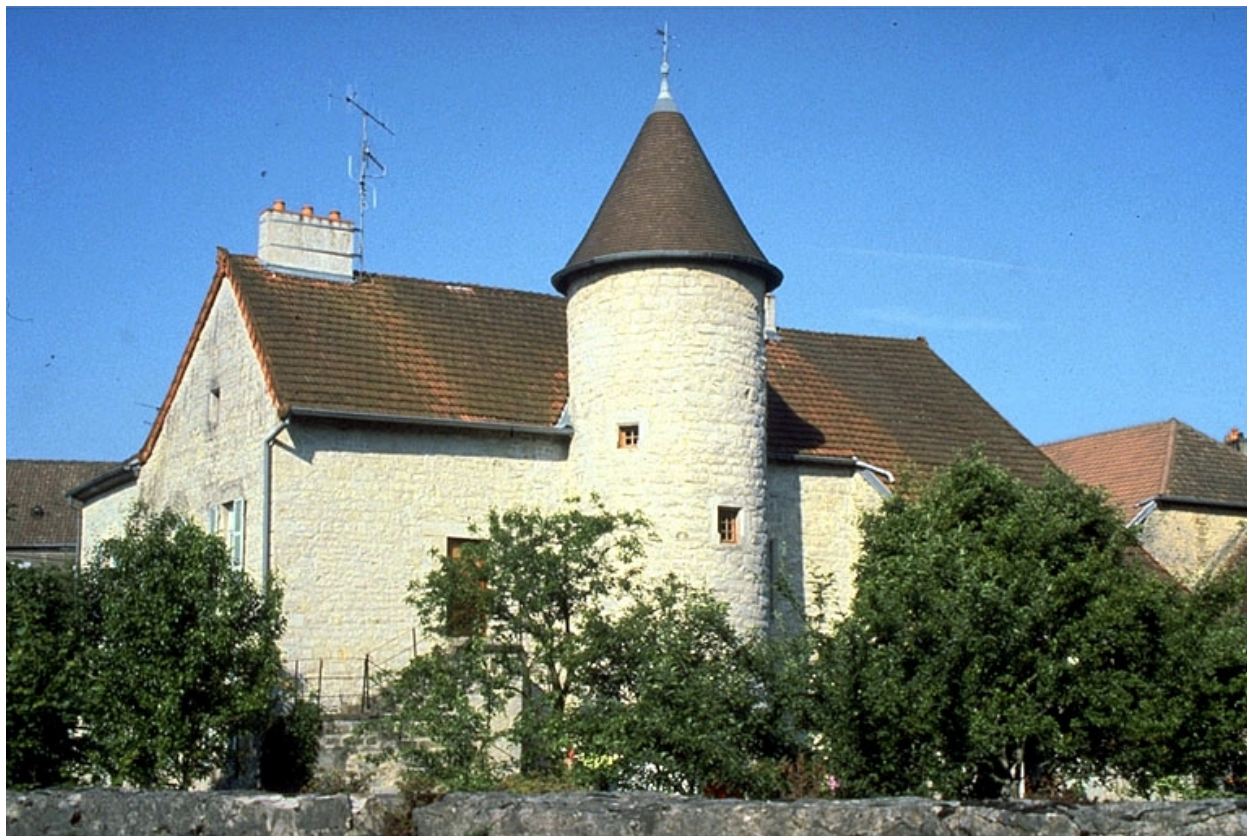
Façade postérieure vue de trois quarts gauche.
