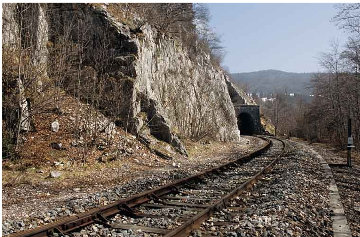
Vue d'ensemble, depuis le nord-ouest (côté Andelot-en-Montagne).
