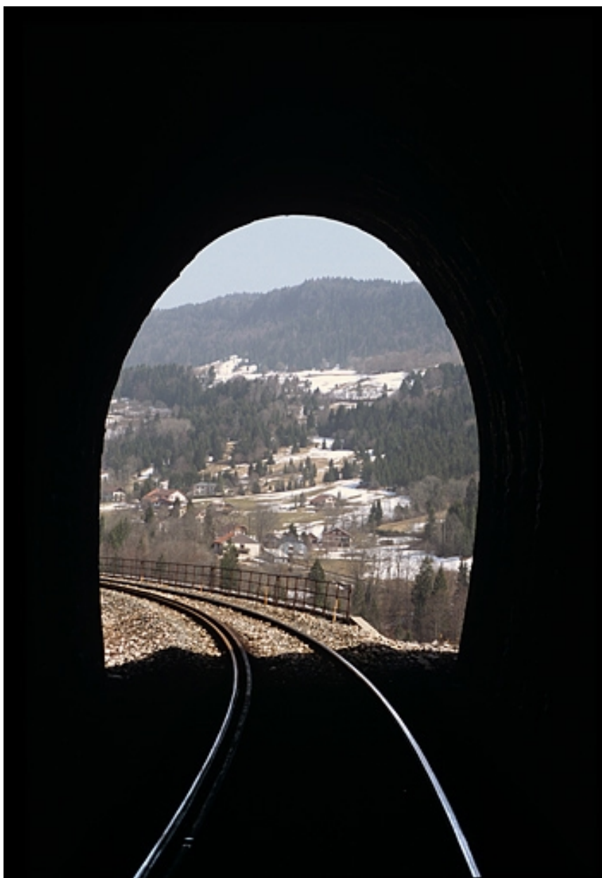
Tête côté La Cluse, depuis l'intérieur.
