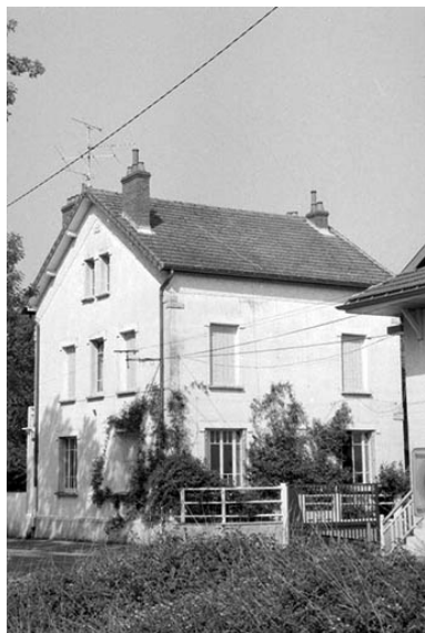
Logement patronal et entrée de l'usine. Phot. Laurent Poupard IVR43_19893901190Z
