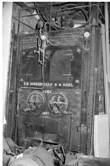
Atelier (C) : chaudière Scheidecker et Kohl. Phot. Laurent Poupard IVR43_19893901191Z
