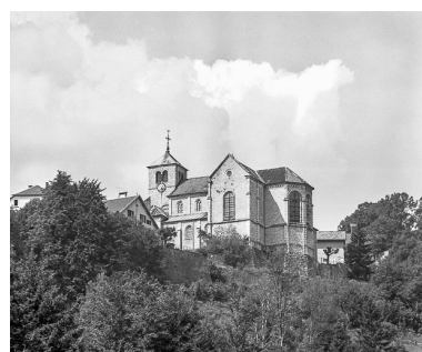
Vue générale depuis le sud en 1979. Phot. Yves Sancey IVR43_19792500444X
