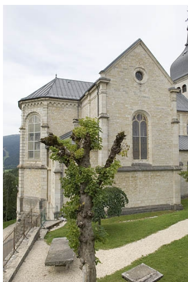
Chevet, depuis l'ouest. Phot. Jérôme Mongreville IVR43_20092501168NUC2A
