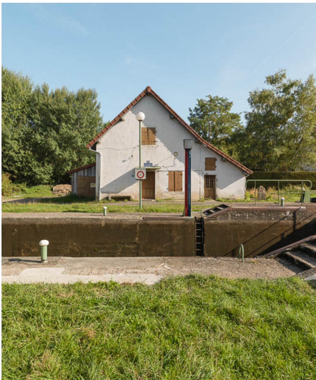
Vue de la maison éclusière.
