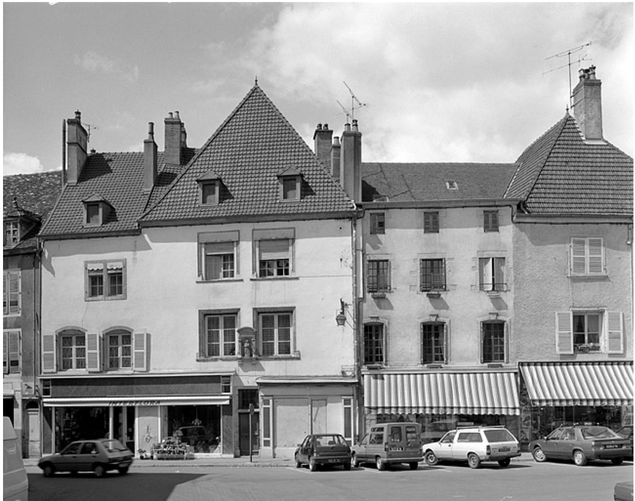
Vue d'ensemble façade antérieure, de face.
