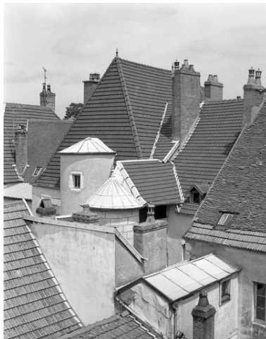
Façade postérieure : vue des toitures. Phot. Yves Sancey IVR43_19917000206X
