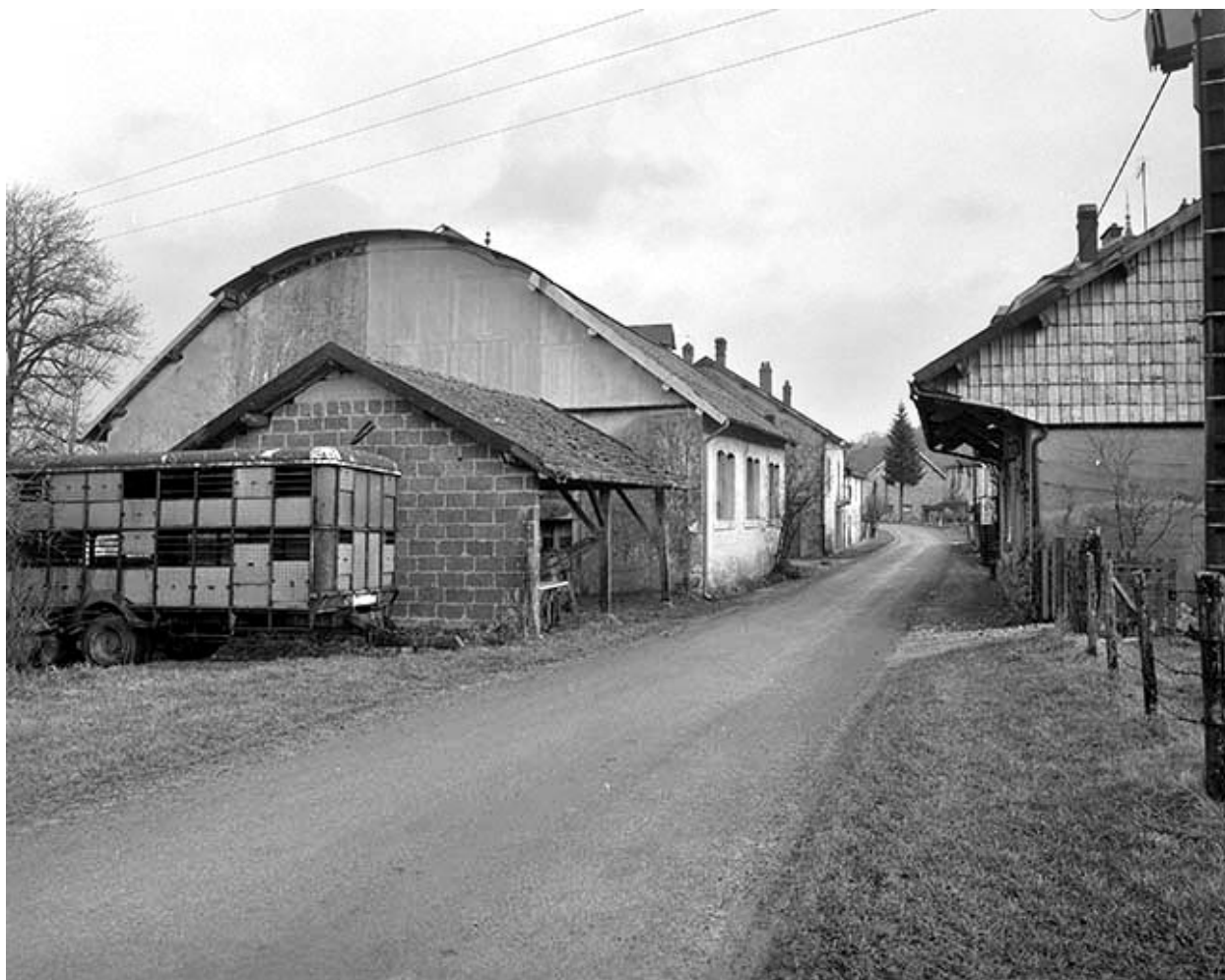
Ateliers de fabrication depuis le sud.
