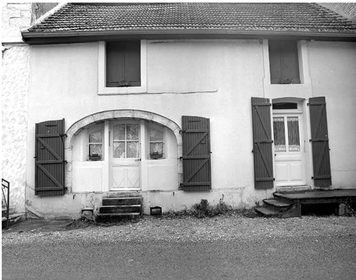
Façade antérieure du logement d'ouvriers.
