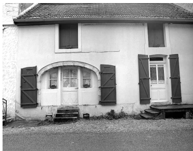
Façade antérieure du logement d'ouvriers.
