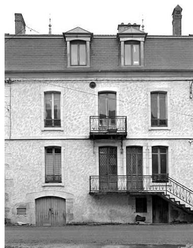
Façade antérieure du logement patronal.
