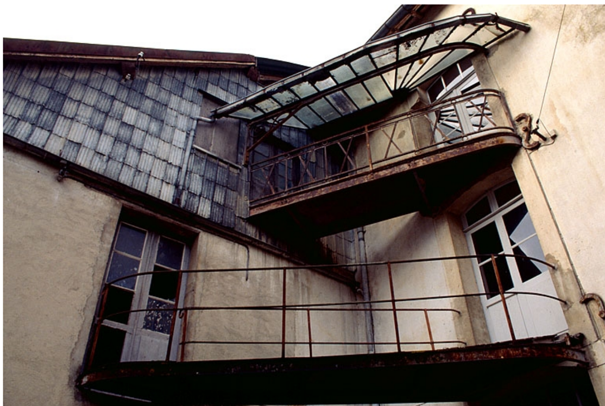
Ateliers de fabrication. Détail des passerelles.
