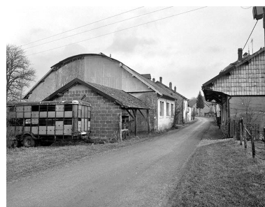
Ateliers de fabrication depuis le sud. Phot. Yves Sancey IVR43_19973900329X
