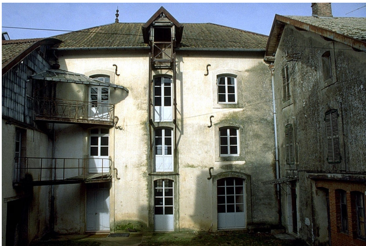
Façade antérieure de l'atelier de fabrication.
