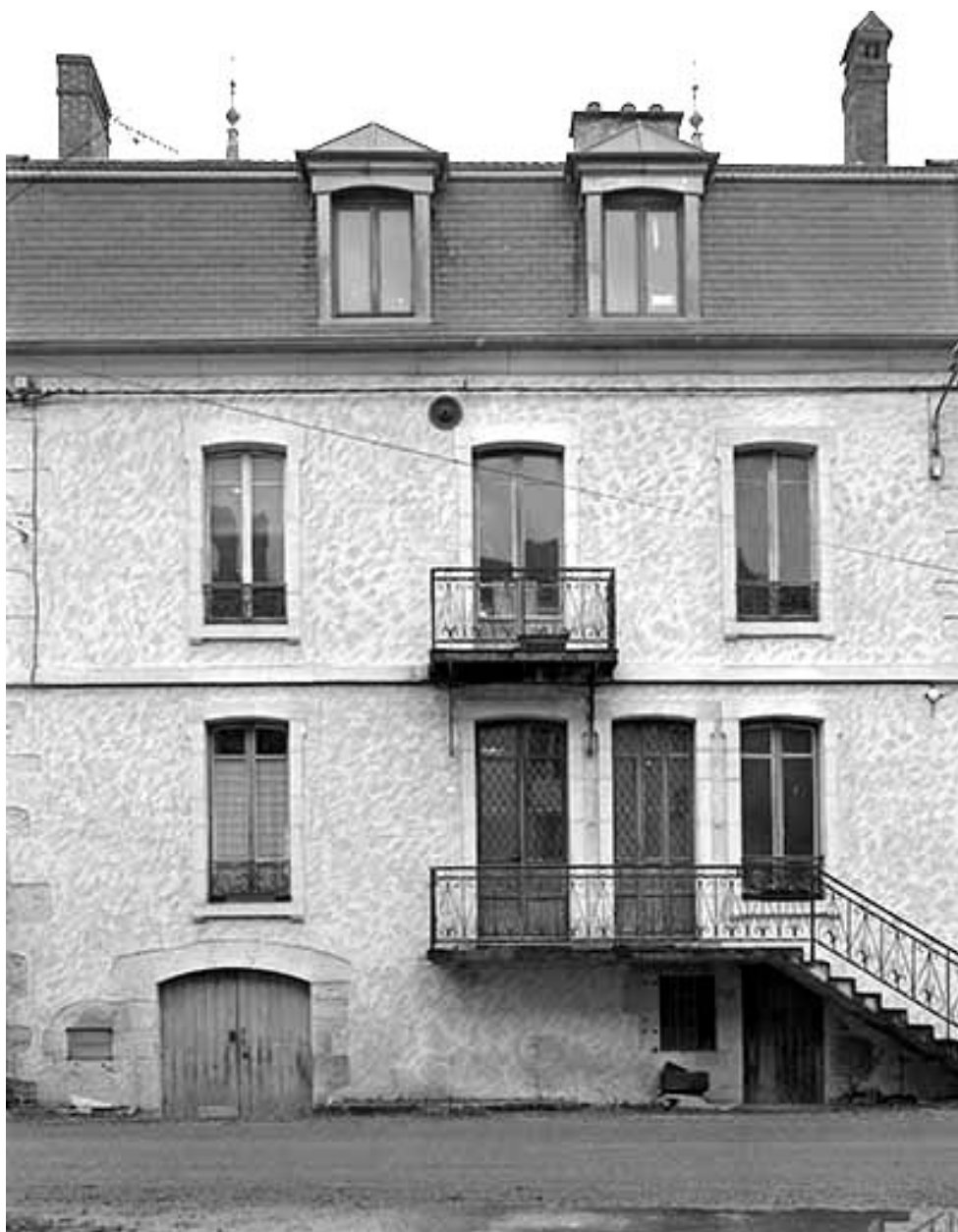
Façade antérieure du logement patronal.
