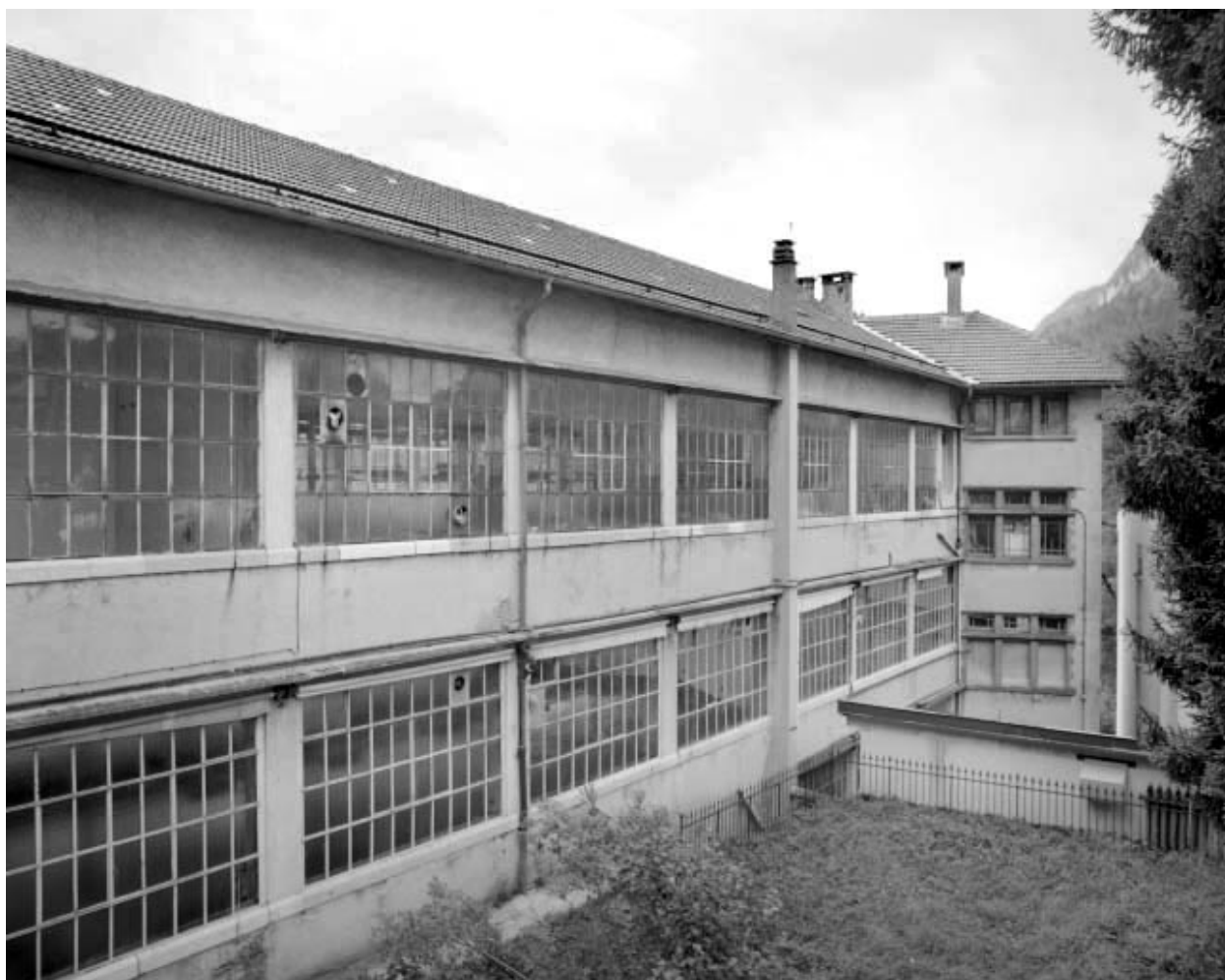
Façade latérale gauche du 2e bâtiment.
