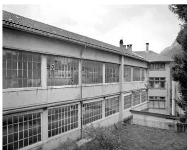
Façade latérale gauche du 2e bâtiment. Phot. Jérôme Mongreville IVR43_19923900638X
