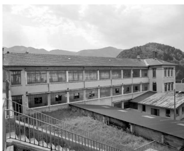
Façade latérale gauche du 1er bâtiment. Phot. Jérôme Mongreville IVR43_19923900639X
