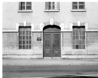
Entrée du 1er bâtiment. Phot. Jérôme Mongreville IVR43_19923900647X
