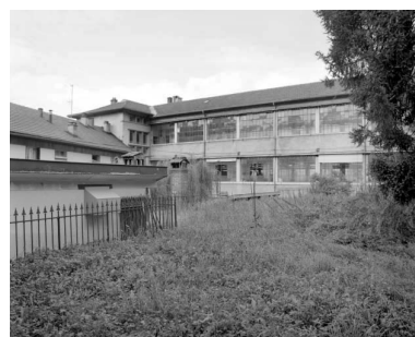
Façade latérale droite du 1er bâtiment. Phot. Jérôme Mongreville IVR43_19923900643X
