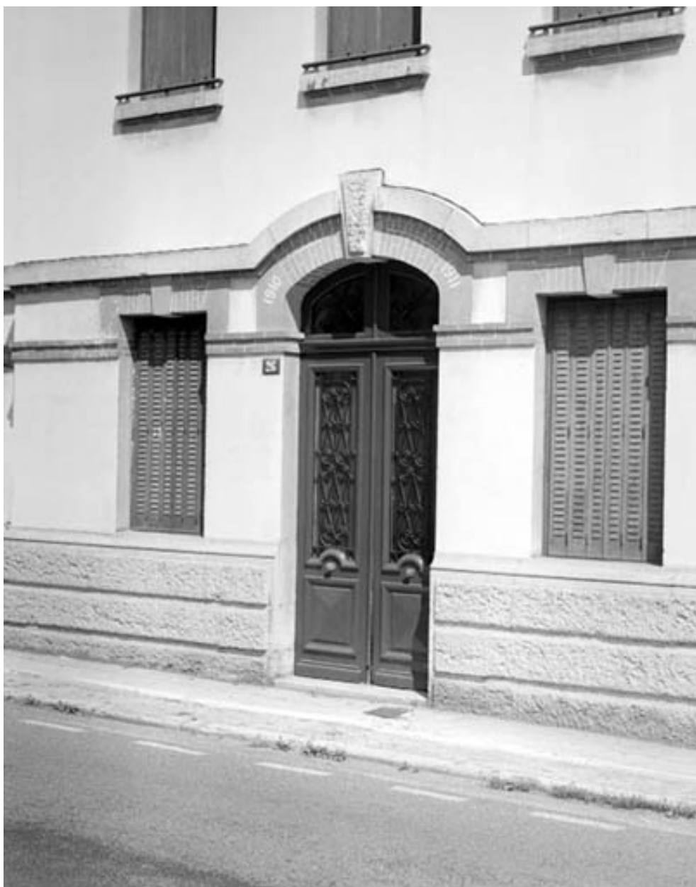
Entrée du 2e bâtiment.
