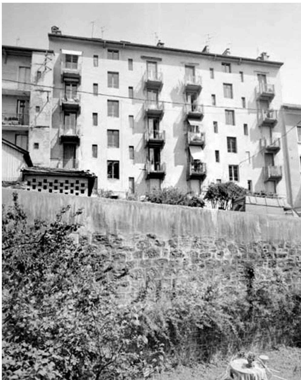
Façade postérieure de l'immeuble aux 15-17, rue Lançon.
