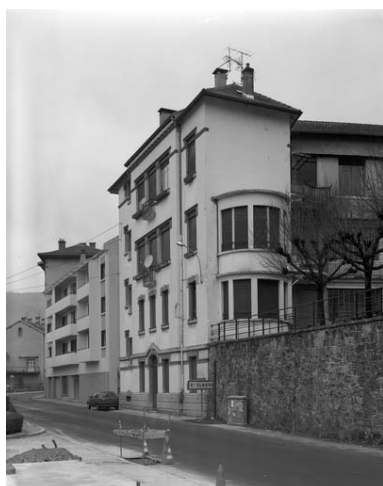
Immeuble de 1970 et 2e bâtiment. Phot. Jérôme Mongreville IVR43_19913900524V
