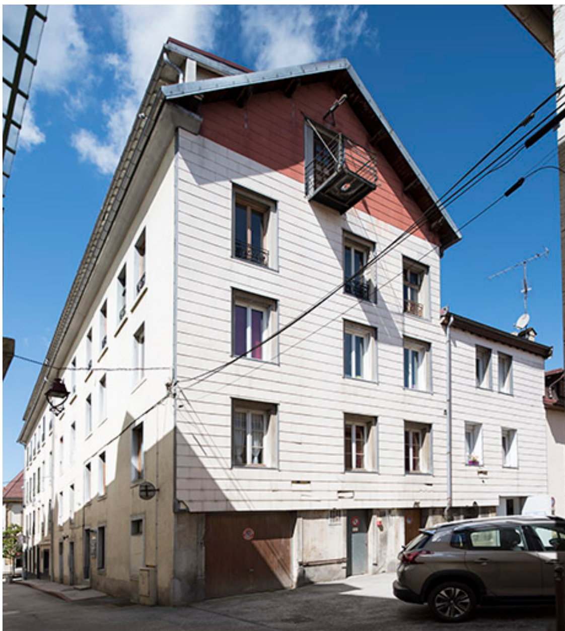
Façades postérieure et latérale droite.
