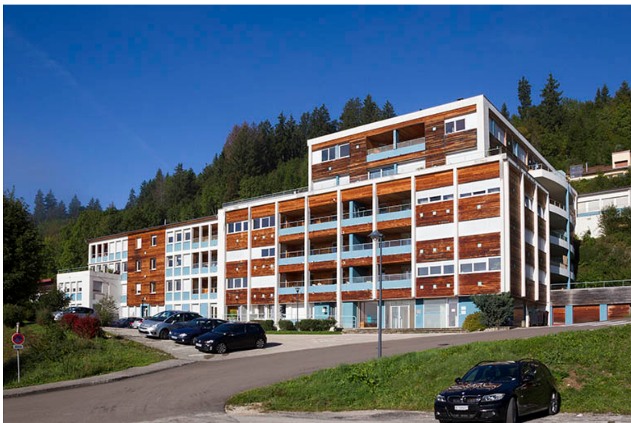
Vue d'ensemble rapprochée, depuis le sud-est.
