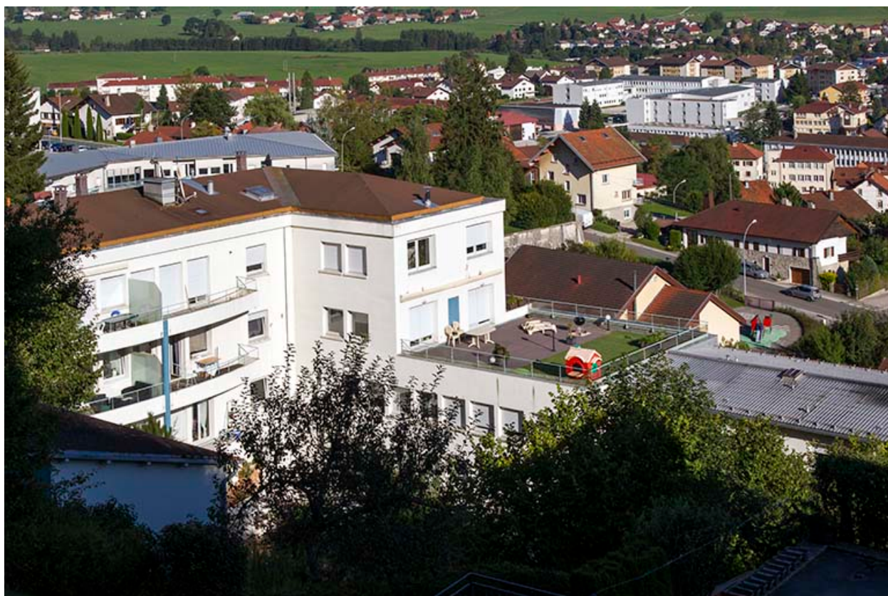
Façades postérieure et latérale gauche (vue plongeante).
