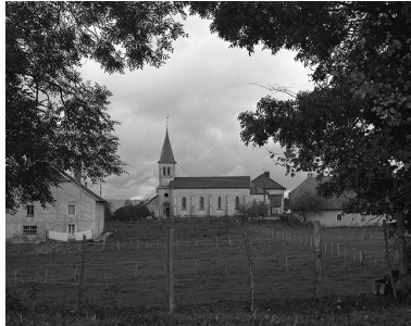
Façade latérale sud. Phot. Dominique Dominguez IVR43_19792500388X
