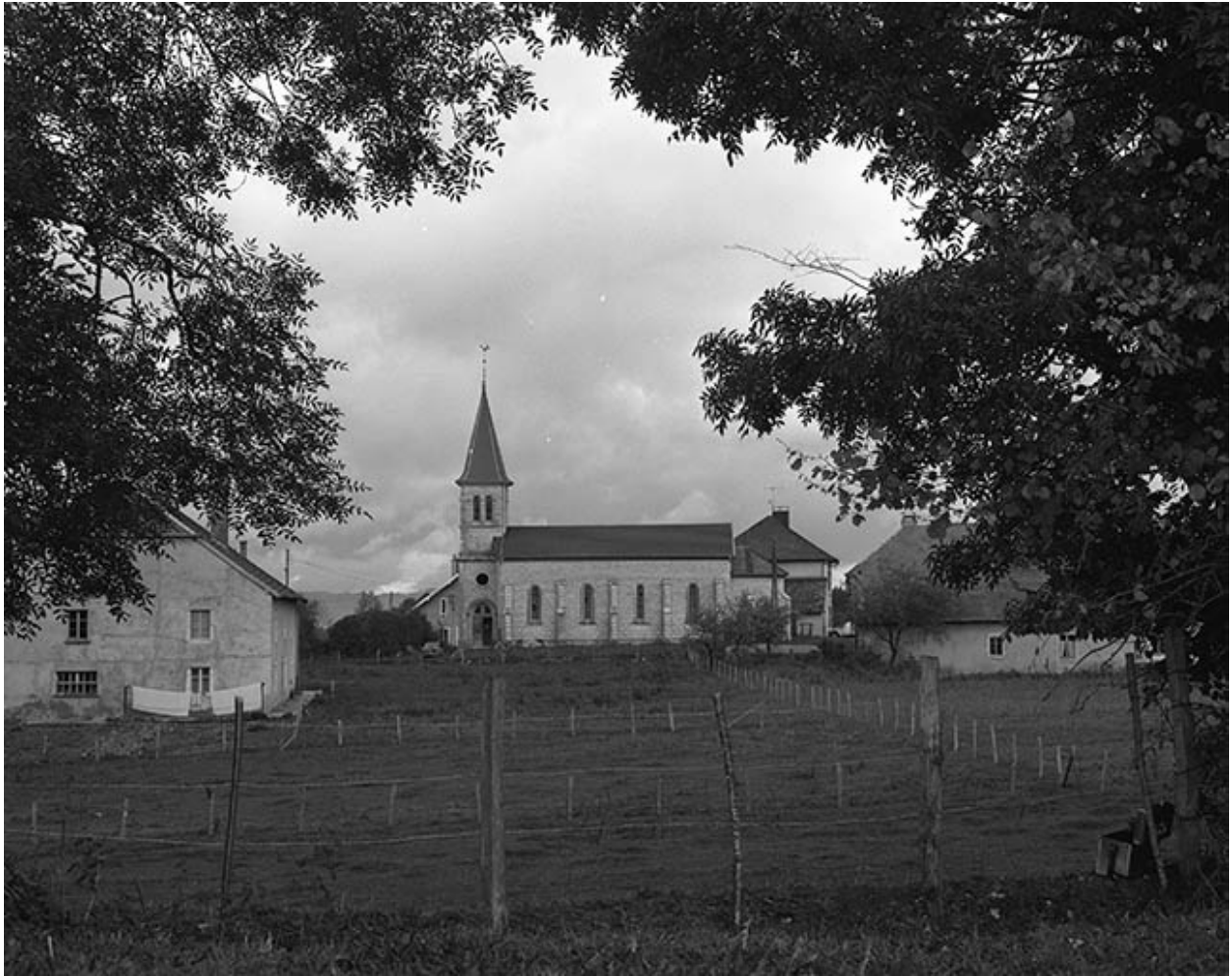
Façade latérale sud.
