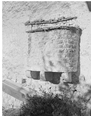
Four accolé en pignon, porté par des consoles en pierres. Phot. Jérôme Mongreville IVR43_19973900750X
