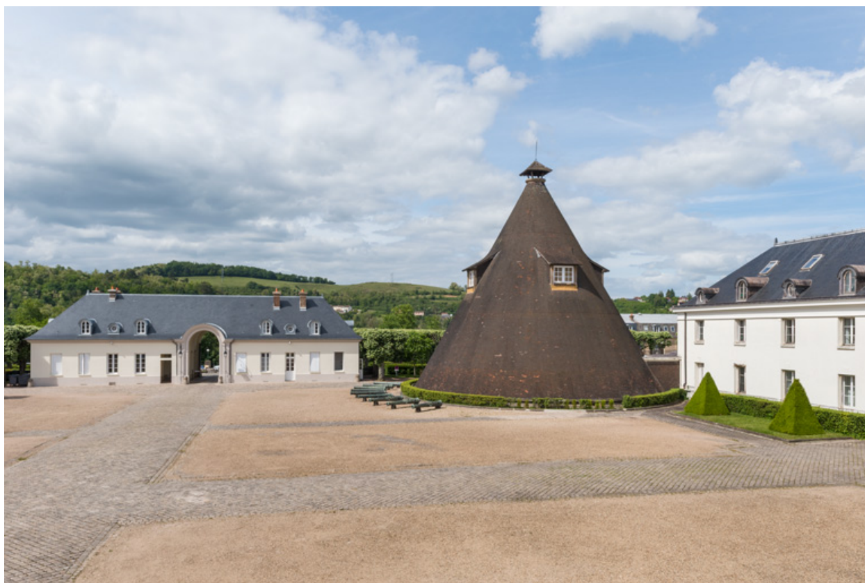
Vue d'ensemble, depuis le sud.
