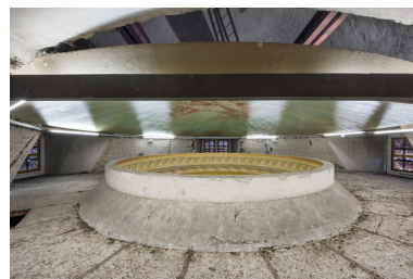
Extrados de la coupole, surmontée de la calotte peinte. Phot. Pierre-Marie Barbe-Richaud IVR26_20257100248NUC4A
