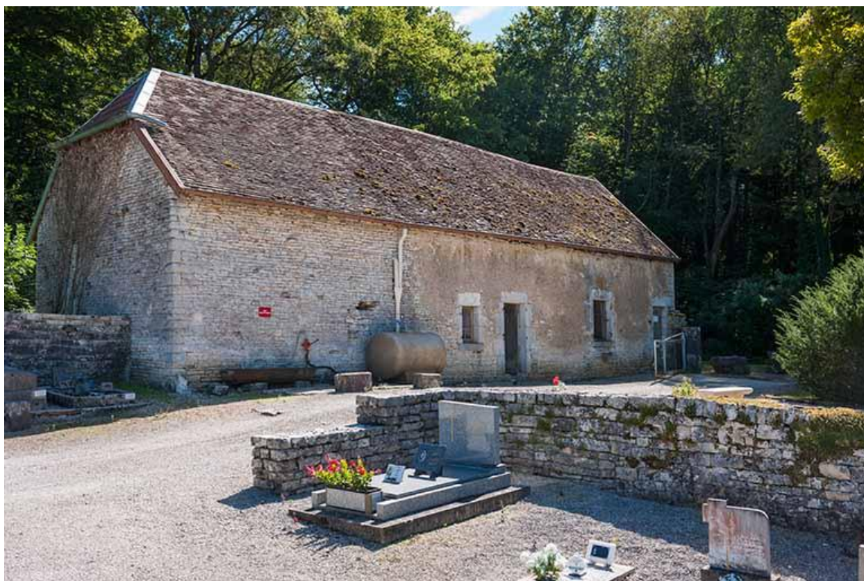
Ancienne ferme située au sud-ouest du cimetière
