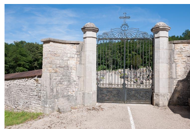
Portail d'entrée Phot. Jérôme Mongreville IVR43_20137000178NUCA
