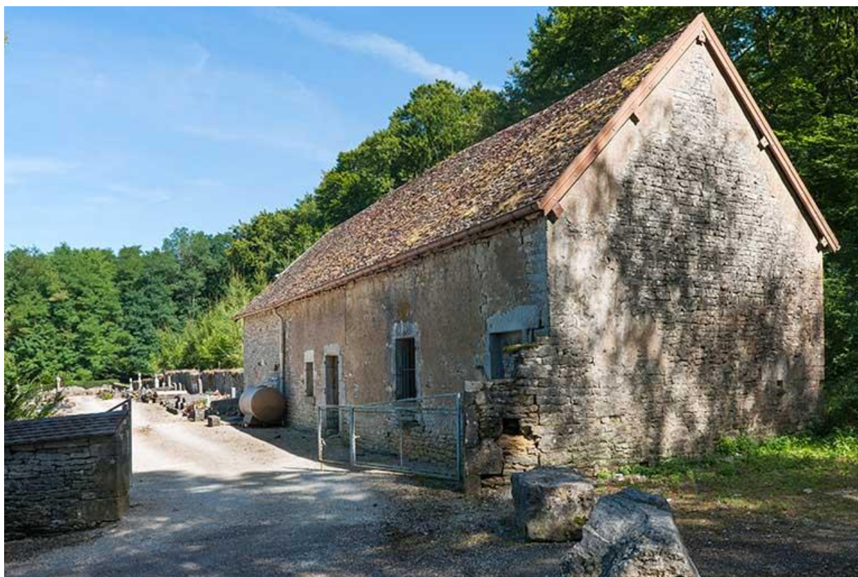
Ancienne ferme située au sud-ouest du cimetière
