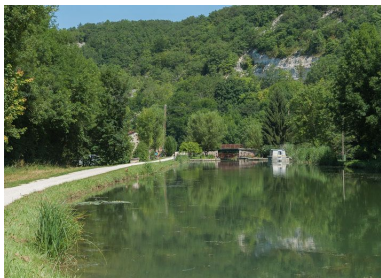
Le site d'écluse vu d'amont. Phot. Pierre-Marie Barbe-Richaud IVR26_20128900361NUC4AQ
