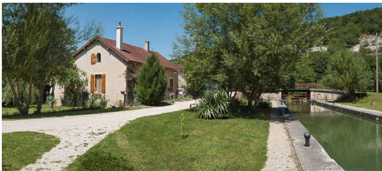
Le site d'écluse vu du sas.
