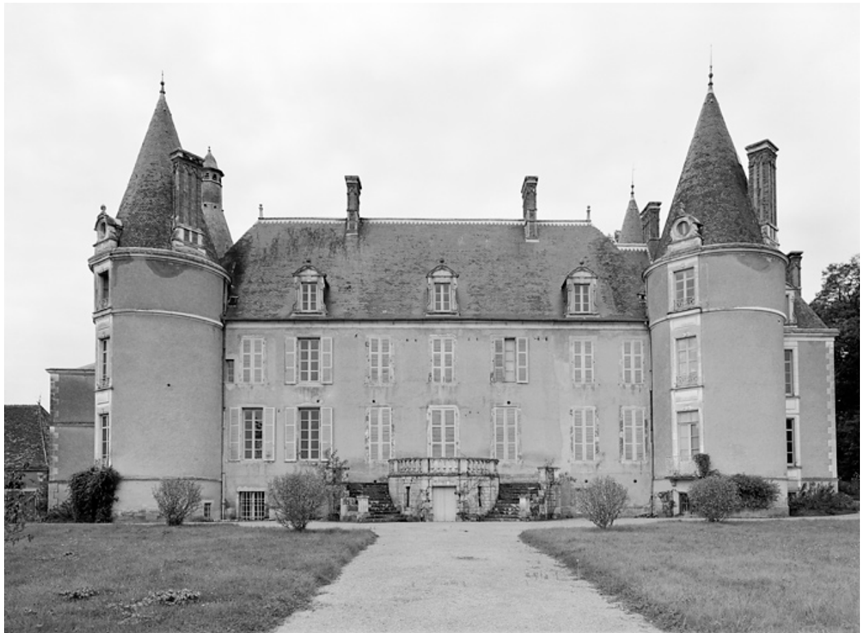
Façade postérieure du logis.
