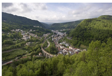
Vue d'ensemble du site de Morez, depuis le viaduc des Crottes au nord. Au premier plan, le viaduc de Paul Séjourné. Phot. Yves Sancey IVR43_20083900731NUC2A
