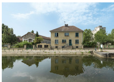
Vue de la maison éclusière, de face. Phot. Pierre-Marie Barbe-Richaud IVR26_20138900158NUC4AQ
