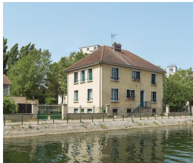
La maison éclusière, vue de 3/4. Phot. Pierre-Marie Barbe-Richaud IVR26_20138900160NUC4AQ
