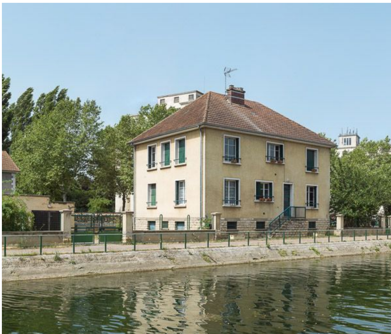
La maison éclusière, vue de 3/4.
