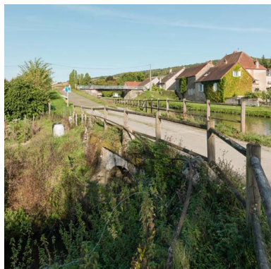
Vue de l'aqueduc.
