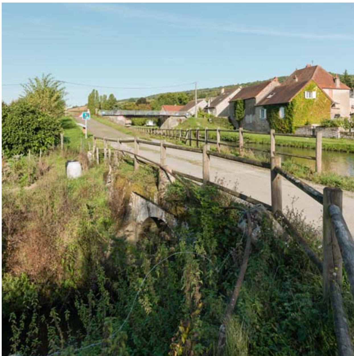
Vue de l'aqueduc.
