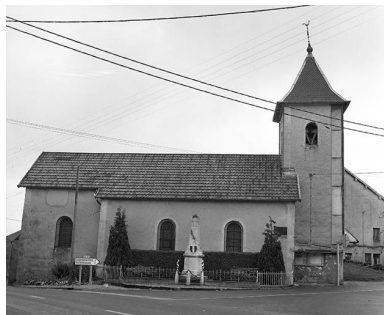
Face latérale gauche. Phot. Yves Sancey IVR43_19762501086X
